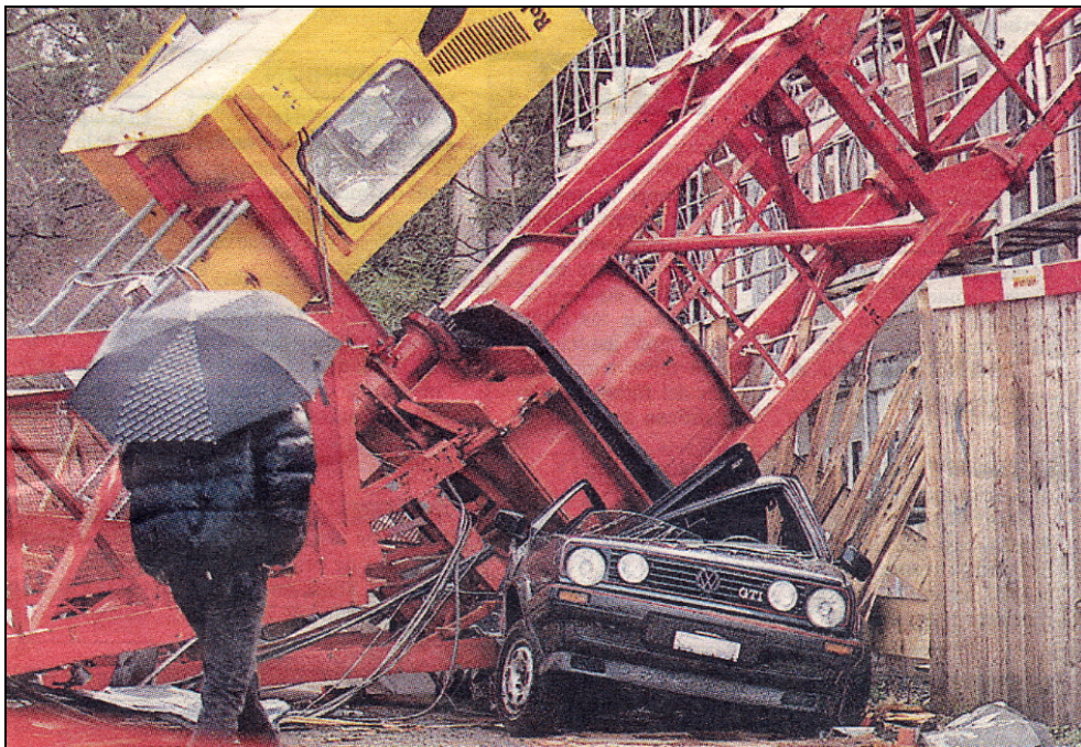
Figura 9.1. Accidente de grúa
