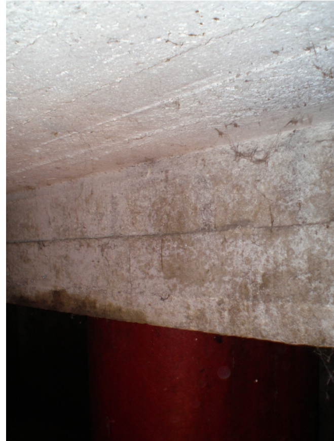
Esquerra: Es pot apreciar la jássera en bon estat en la seva unió amb una de les biguetes. Dreta: La bigueta amb unes sospitoses taques a la part inferior del cantell.
