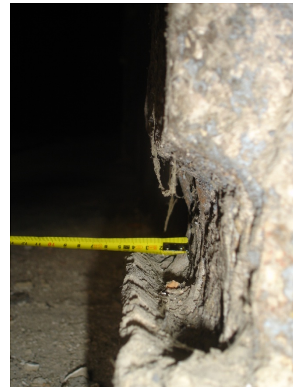
S'anoten les dimensions del tall i s'aprofita l'ocasió per analitzar el recobriment i l'estat de les barres.
