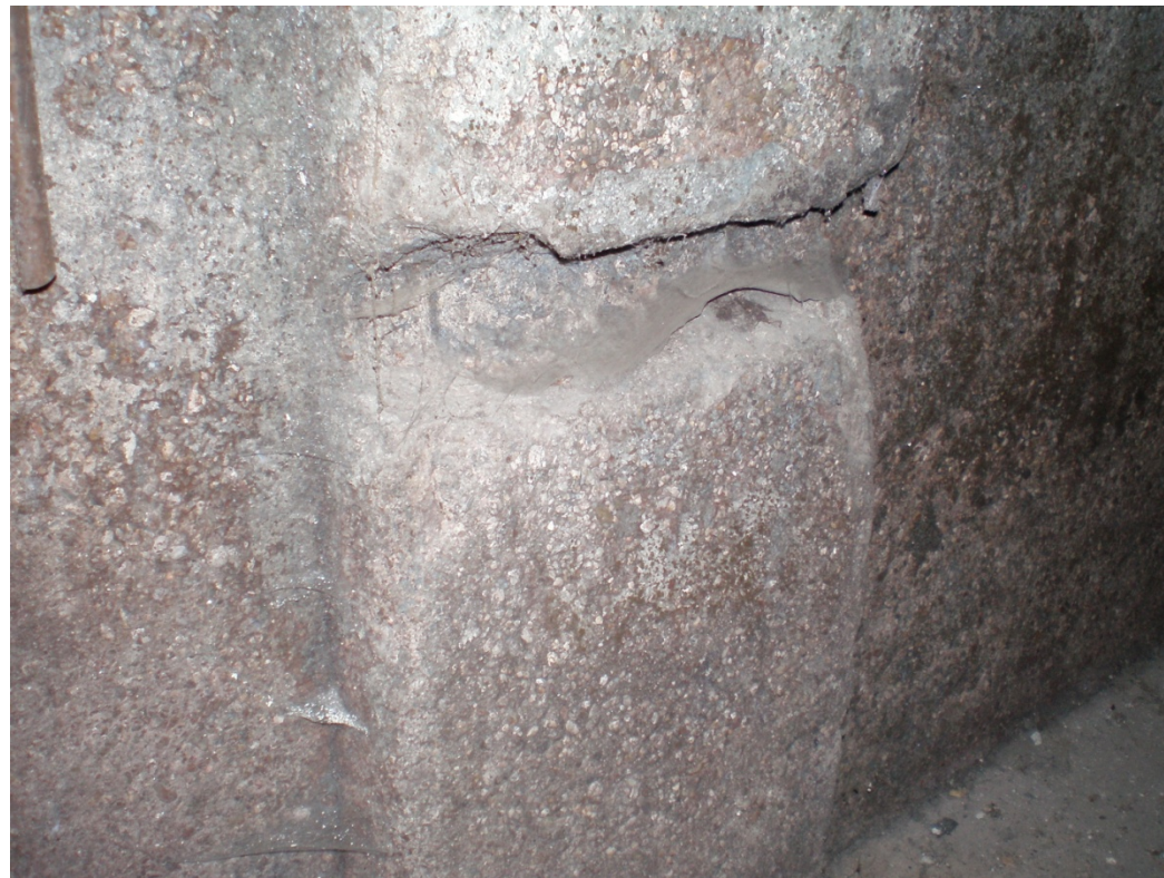
Aquesta pèrdua de secció és fruit de la solució adoptada per fer passar conduccions de sanejament.
