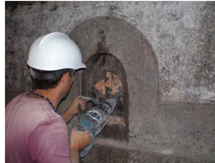
Les antigues boques inferiors d'accés als dipòsits van ser tapiades amb parets de maó.
