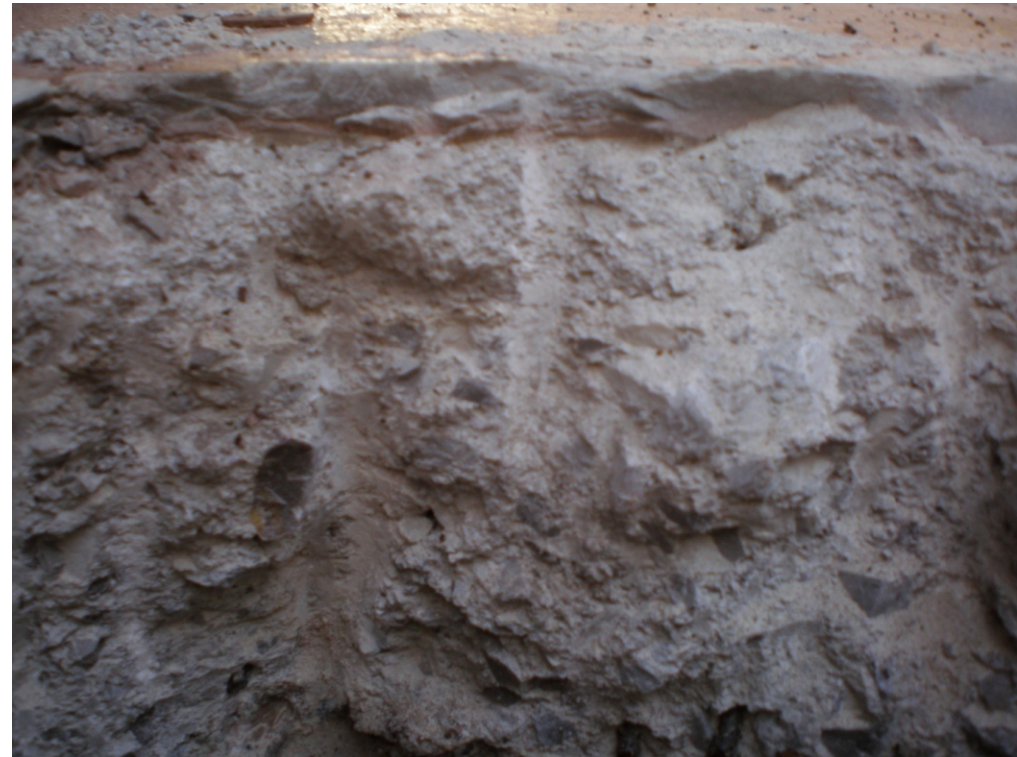
Ens permet verificar el cantell de la llosa de formigó, que és de 20 cm.
