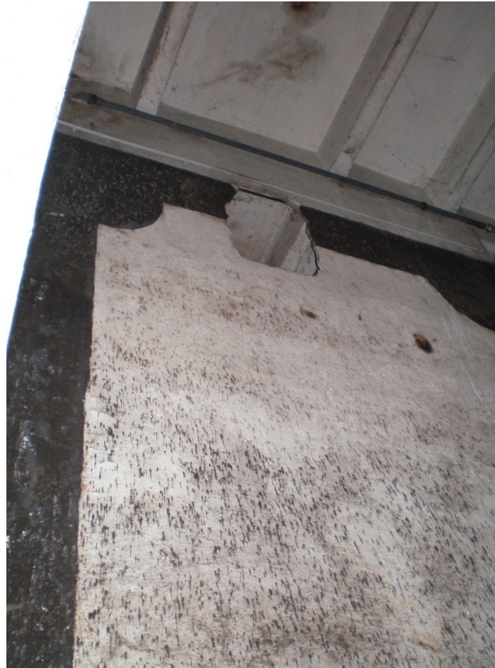
El tancament dels dipòsits és de formigó armat, el tram final que l'uneix al sostre s'acaba amb una paret de tapia. L'interior dels dipòsits està impermeabilitzat per evitar filtracions.
