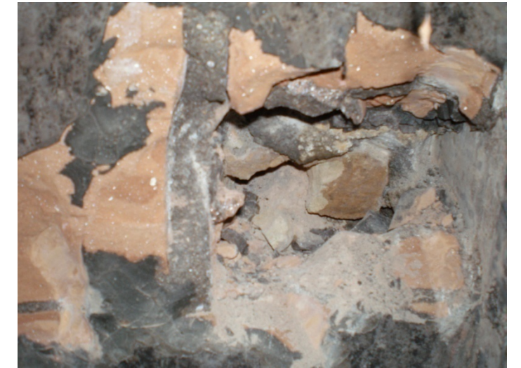
Les antigues boques inferiors d'accés als dipòsits van ser tapiades amb parets de maó.
