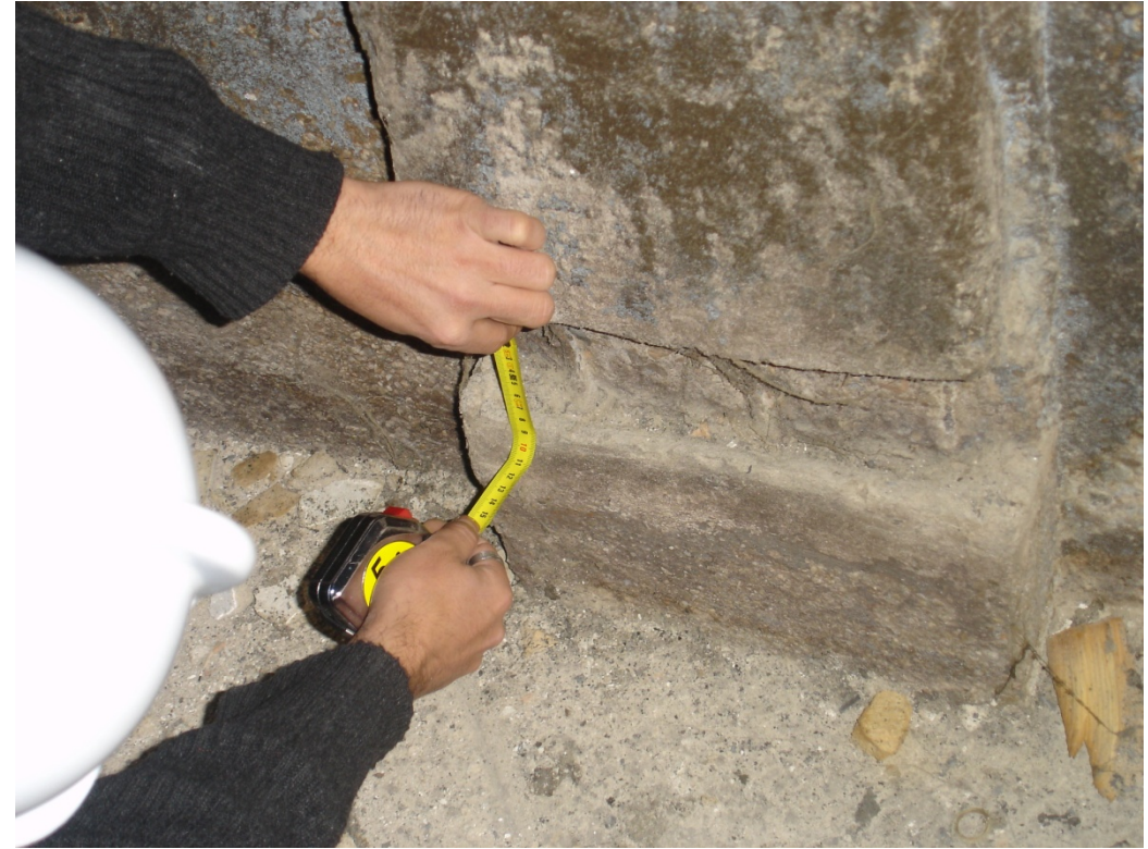
S'anoten les dimensions del tall i s'aprofita l'ocasió per analitzar el recobriment i l'estat de les barres.
