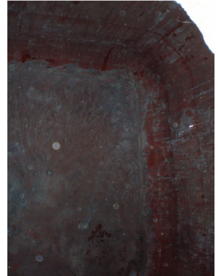
El tancament dels dipòsits és de formigó armat, el tram final que l'uneix al sostre s'acaba amb una paret de tapia. L'interior dels dipòsits està impermeabilitzat per evitar filtracions.
