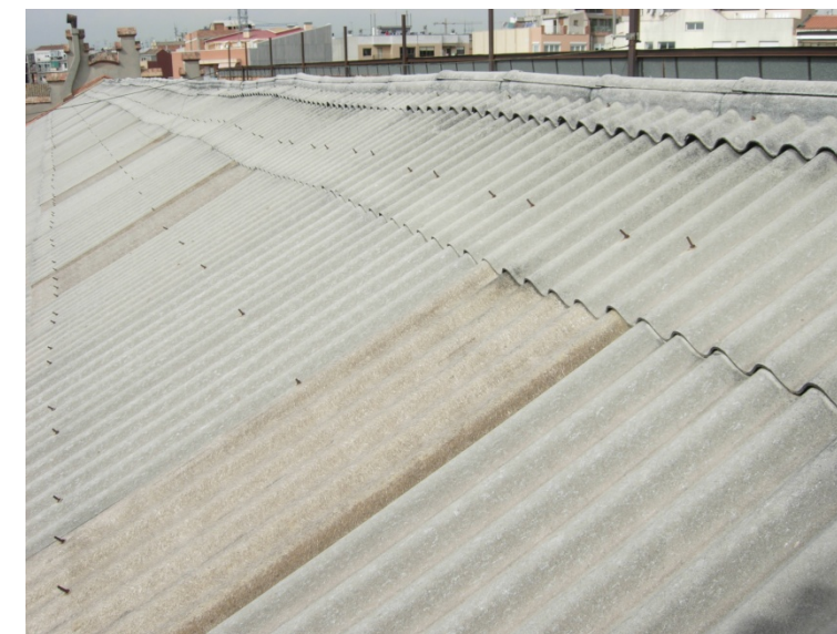
Estat actual de la coberta
