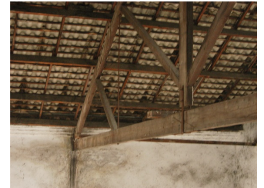
Recolzament de l'encavallada
