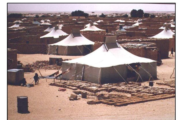
Fotografia 26: Haima on s'observa la preparació d'atovons per l'aixecament d'una habitació
