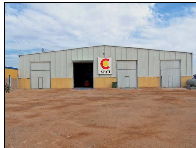
Fotografia 42: Nau del taller mecànic feta amb un mur base de bloc de formigó i la resta de parament amb panells sandvitx
