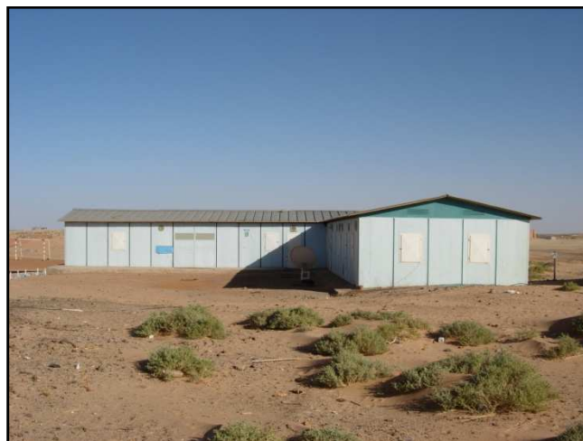
Fotografia 41: Mòdul prefabricat amb panells sanvitx
