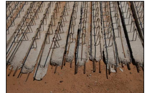
Fotografia 40: Bigues fabricades in situ
