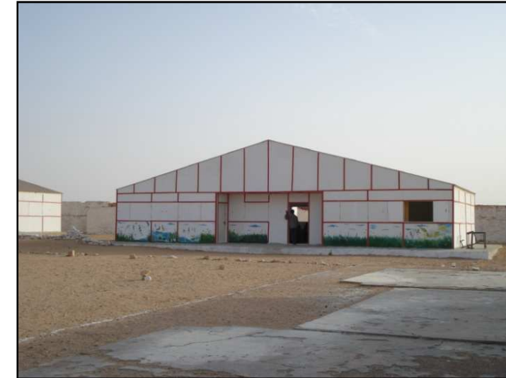
Fotografia 43: Mòdul de prefabricat de fusta
