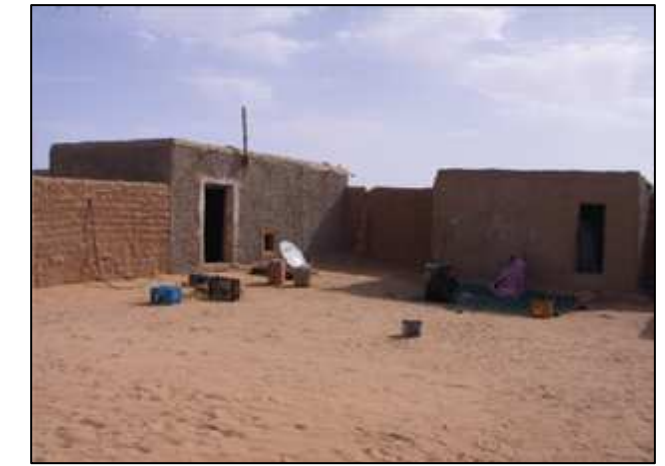
Fotografia 30: Fotografia de més habitacions. En una d'elles s'observa una habitació arrebossada amb morter de ciment
