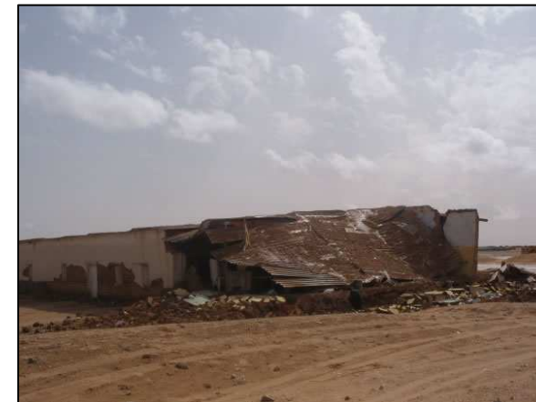
Fotografia 8: Edifici públic on s'han col·lapsat els murs de càrrega fets amb atovons de terra
