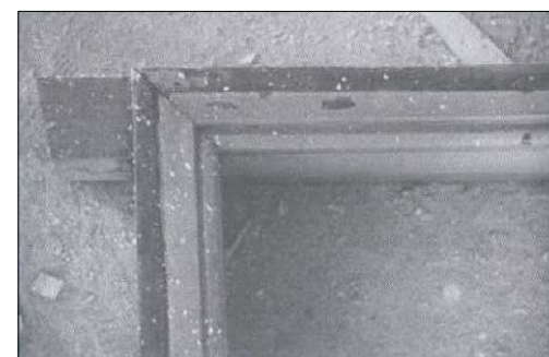
Detall de bastiment amb banyots per tal d'encastar-los a l'interior de l'obra
