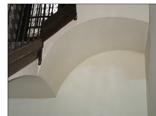
Volta d'escala de maó pla
