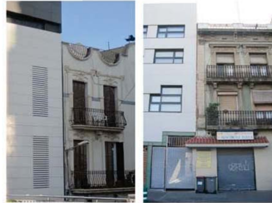
II.2 - F.16 - Juntas entre fachadas nuevas y antiguas
