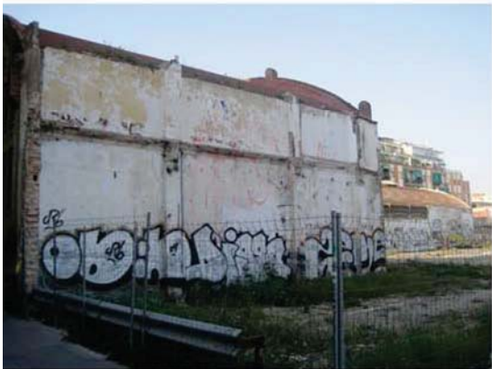
II.2 - F.15 - Fachada medianera
