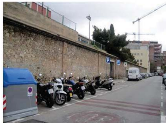
II.2 - F.18 - Muro
