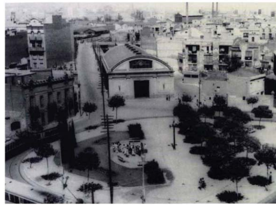
II.3 - F.06 - Fotografía de la estación de 1936
