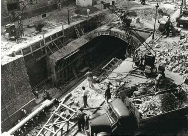
II.1 - F.05 - Cubrición de las vías del Carrer d'Aragó, 1960
