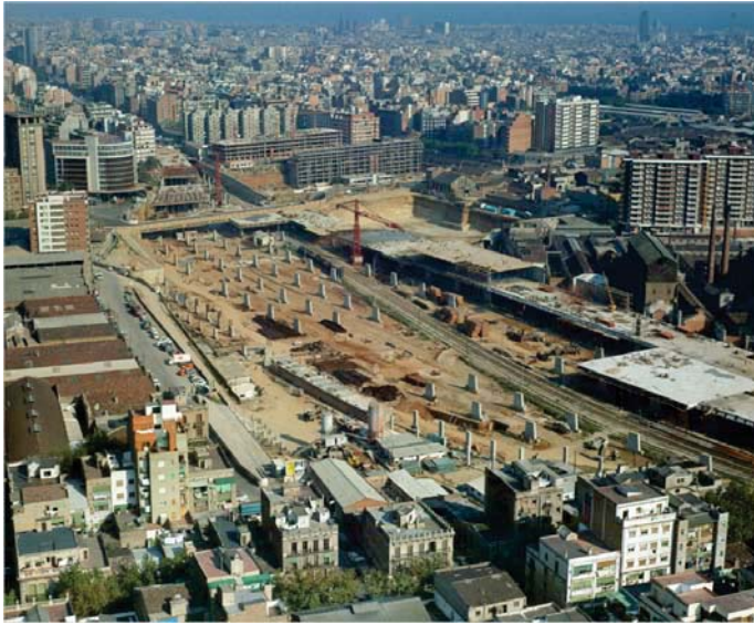
II.1 - F.09 - Construcción de la cubierta de los andenes de la estación actual: una topografía artificial
