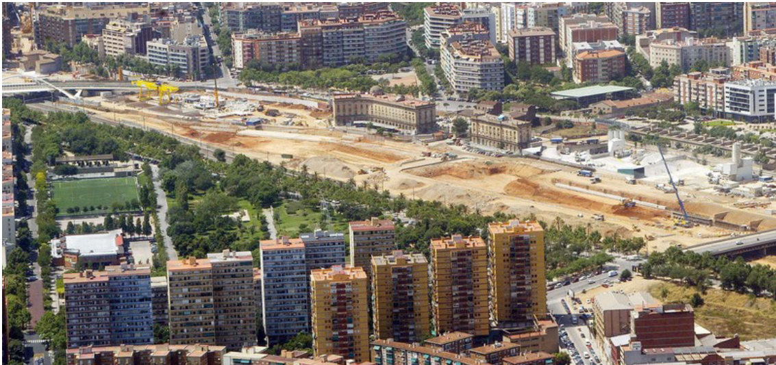
I.2 - F.19 - Fotografía aérea del Parc de Sant Martí y las obras de remodelación de la futura estación, 2010
