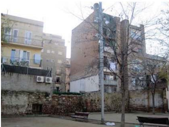
II.2 - F.17 - Fachada trasera
