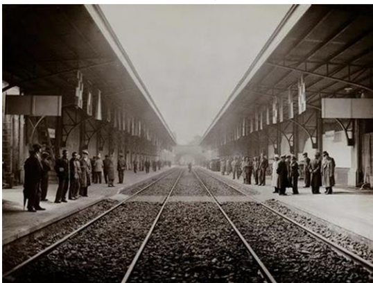
II.1 - F.13 - Andenes de la Estació de Sants, 1936
