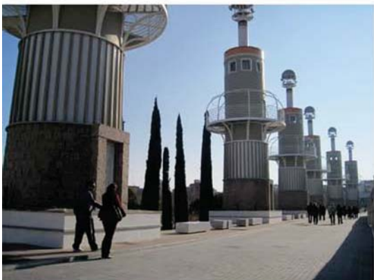
II.2 - F.19 - Torres de iluminación
