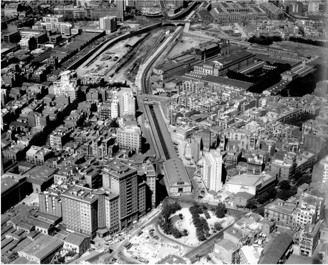
I.2 - F.26 - Antigua Estació de Sants, 1967
