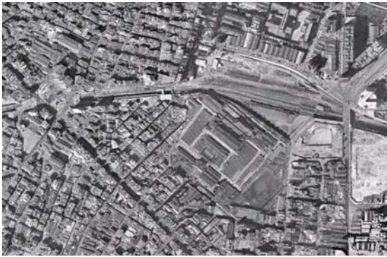
II.3 - F.10 - Fotoplano de 1970. La estación ha sido demolida y se ha construido la provisional en el Carrer Vallespir
