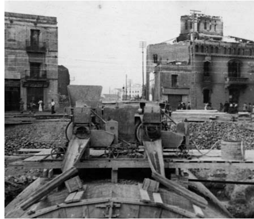
II.1 - F.06 - Obras del túnel de la Plaça de Sants, 1936
