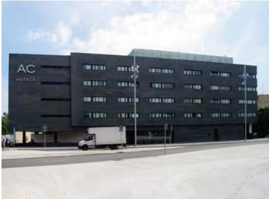
II.2 - F.13 - Fachada nueva
