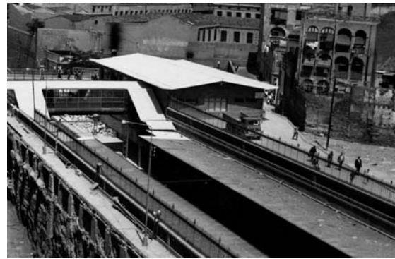
II.3 - F.13 - Estación provisional sobre el antiguo puente de Vallespir (1970)
