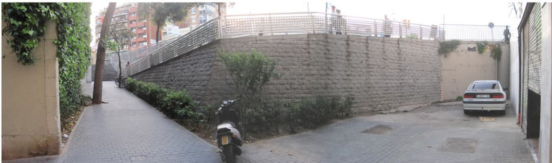
II.1 - F.20 - Esquemas de la escalera del Carrer de Riego Fotografía de la escalera, vista rampa desde Pg. de Sant Antoni, y panorámica desde el Carrer de Riego
