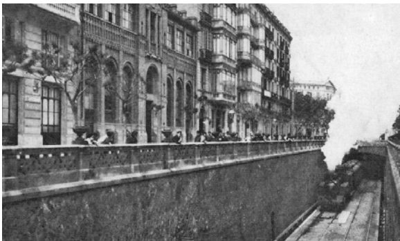
II.1- F.03 - Zanja del Carrer d'Aragó, entre Rambla de Catalunya y Passeig de Gràcia, 1915
