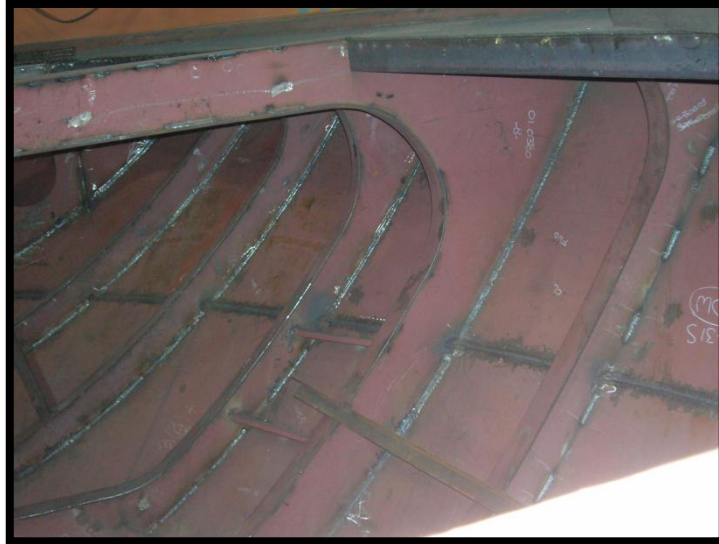
Imagen 10.1 Detalle soldadura doble fondo del buque
