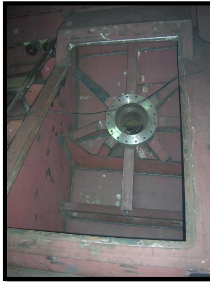
Imagen 10.6 Detalle cofferdam con toma de mar
