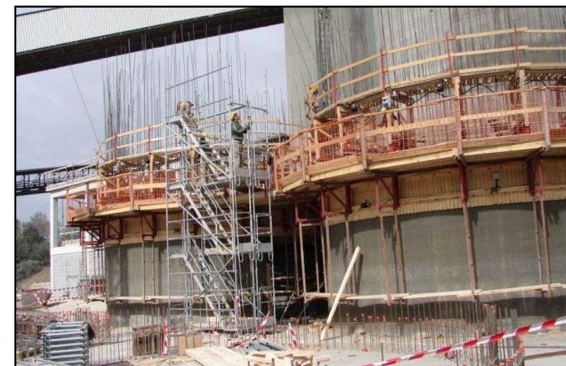
Muntatge de l'escala d'accés
