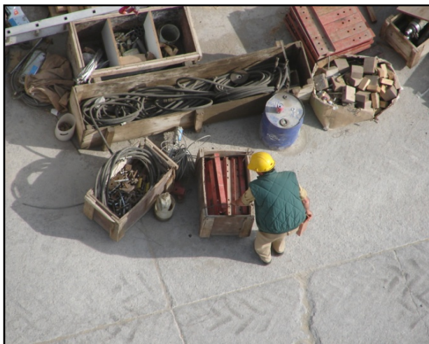
Inici del muntatge de l'encofrat
