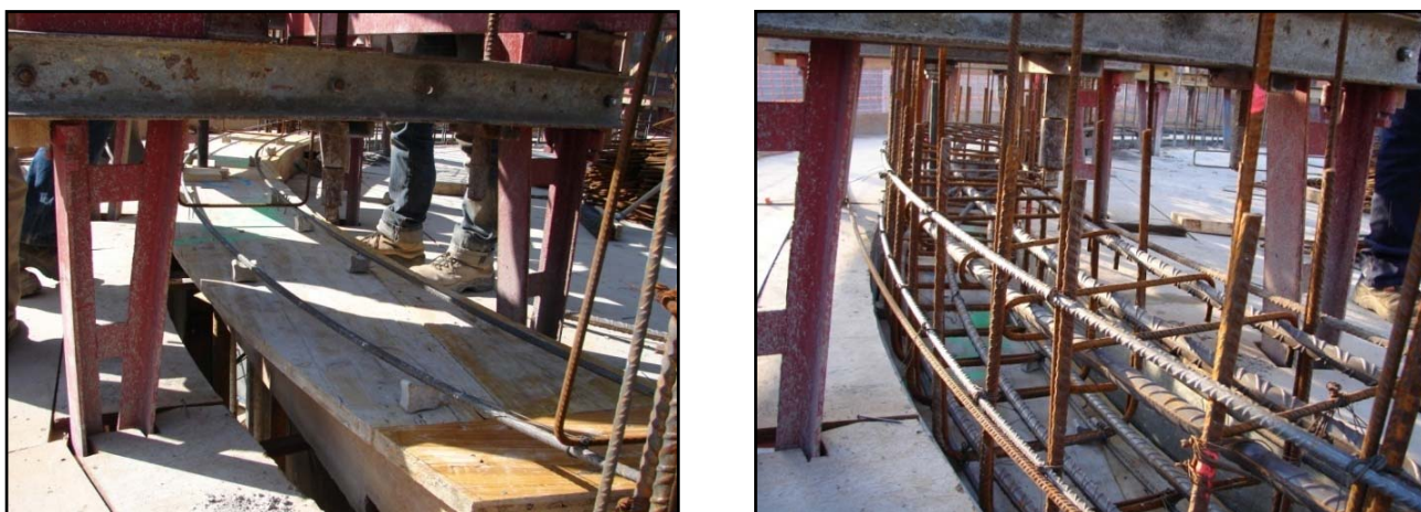
Procés de construcció de les llindes de les portes
