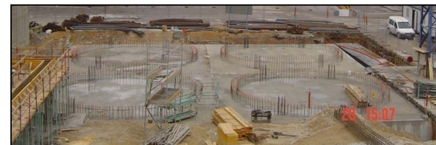
Vista general de la fonamentació un cop acabada
