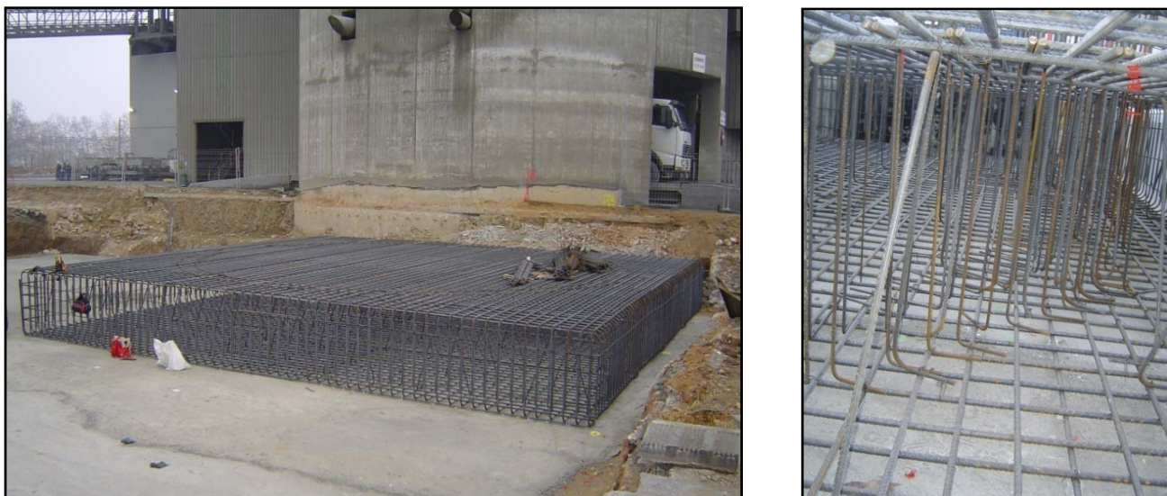
Vista de la llosa de fonamentació i detall de les esperes
