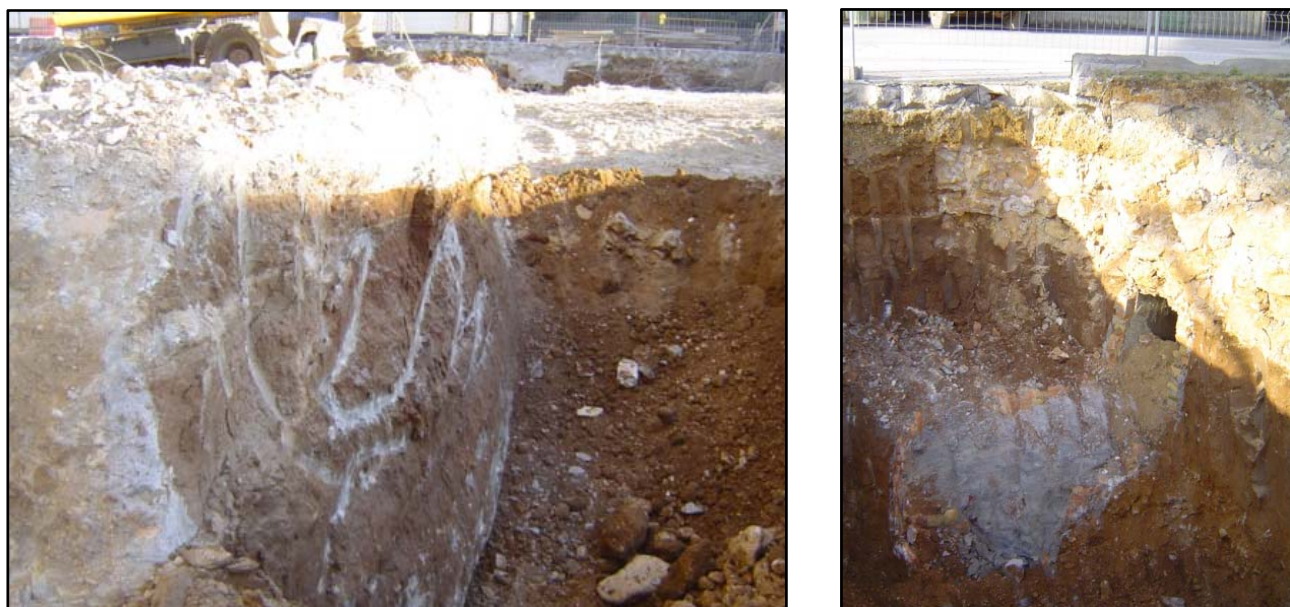
Presència d'elements de formigó i antigues galeries de serveis
