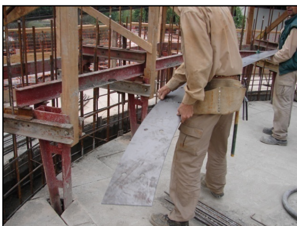
Col·locació de les platines de posicionament dels pernns
