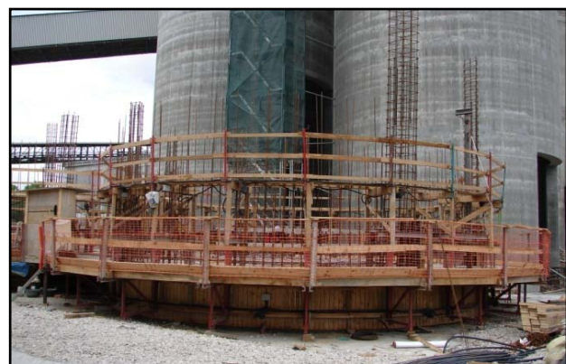
Encofrat preparat per a iniciar el lliscat
