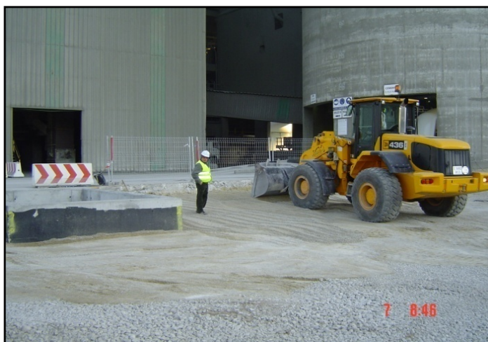
Procés de reomplert per a l'edifici de control de motors
