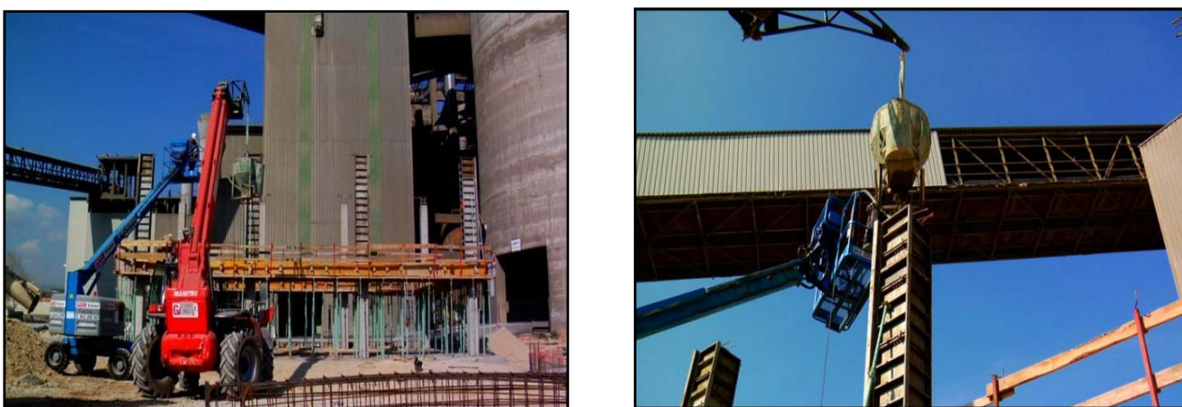
Formigonat dels pilars mitjançant una merlo
