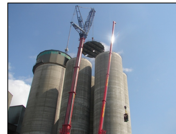
Col·locació del forjat superior de les sitges
