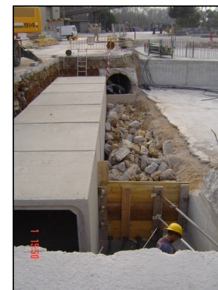
Treballs sota nivell d'acabat
