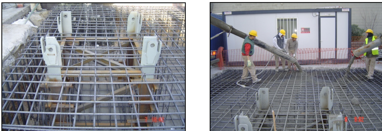
Fonamentació de la grua
