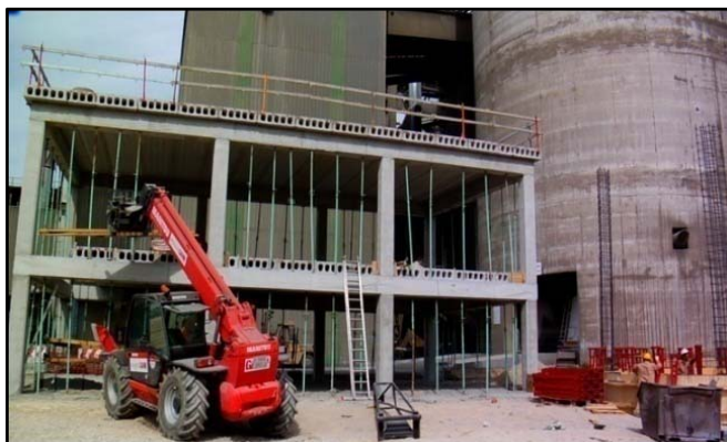
Edifici de control de motors
