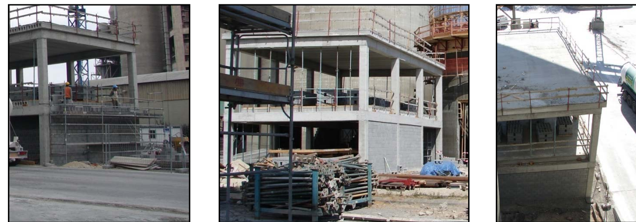
Procés de construcció dels tancaments de bloc
