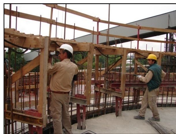
Col·locació de les platines de posicionament dels pernns
