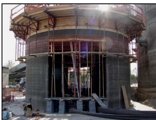
Vista de la llinda acabada de les portes exteriors
