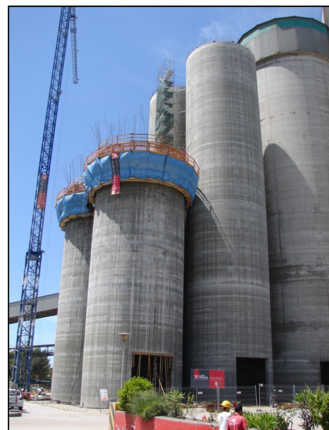
Estructura de les sitges
