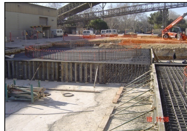
Procés d'encofrat i formigonat amb bomba
