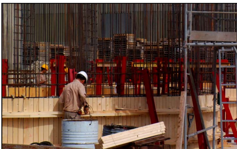
Col·locació de les cavallets i detall de la unió mitjançant una biga
