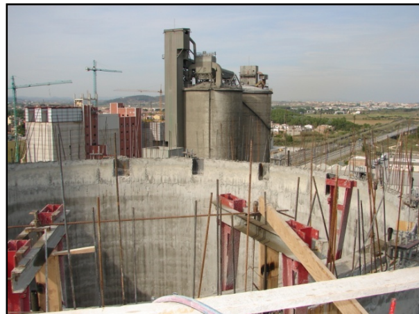
Imatges del procés de desmuntatge de l'encofrat
