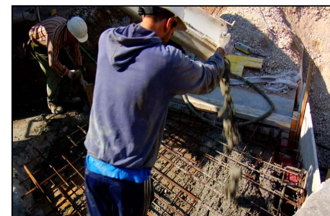
Formigonat d'una trobada entre les galeries existents i les noves galeries
