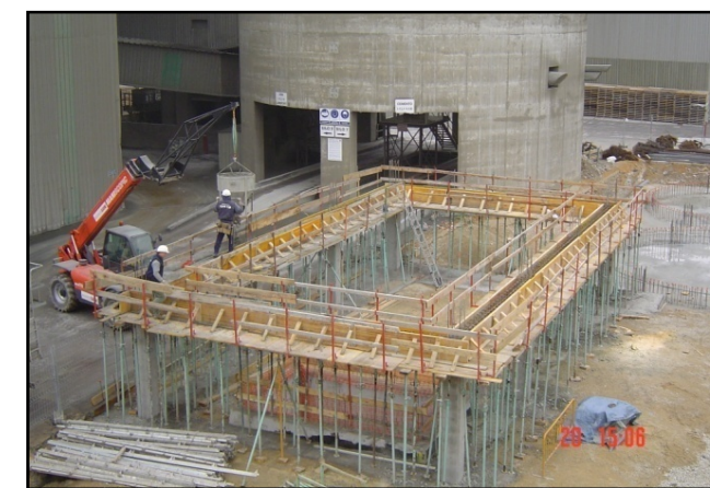
Vista general d'edifici de motors en fase de formigonat de jàsseres
