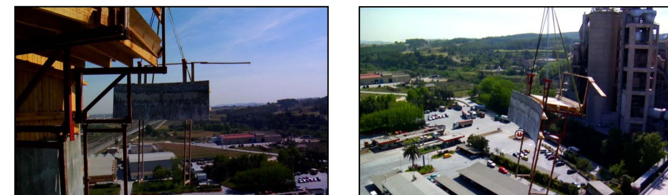
Procés de desmuntatge de l'encofrat exterior
