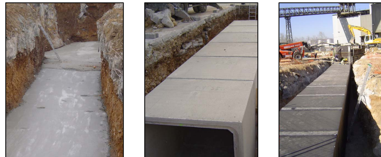
Procés de col·locació de les galeries prefabricades
