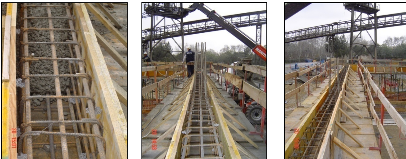
Detall i vista de les jàsseres encofrades i en procés de formigonat
