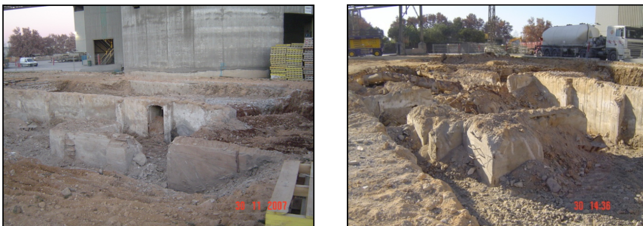
Vista general de l'excavació
