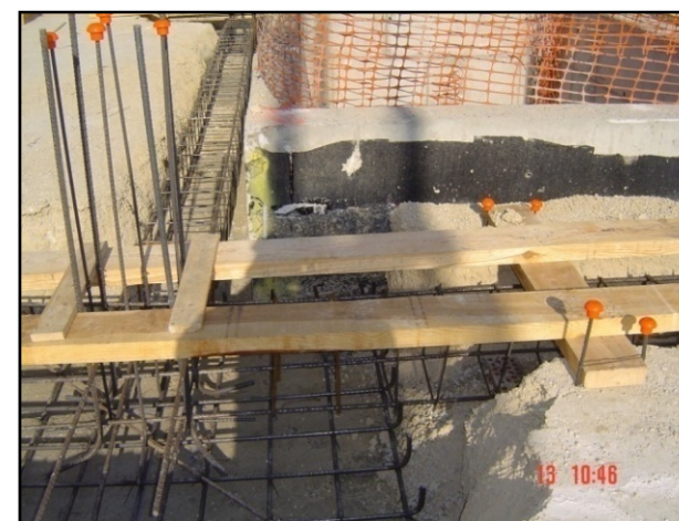
Fonamentació de l'edifici de control preparada per a formigonar
