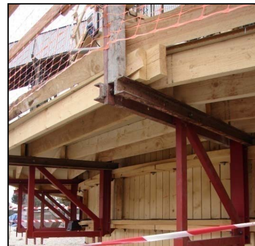
Suports exteriors i interiors de la plataforma de treball
