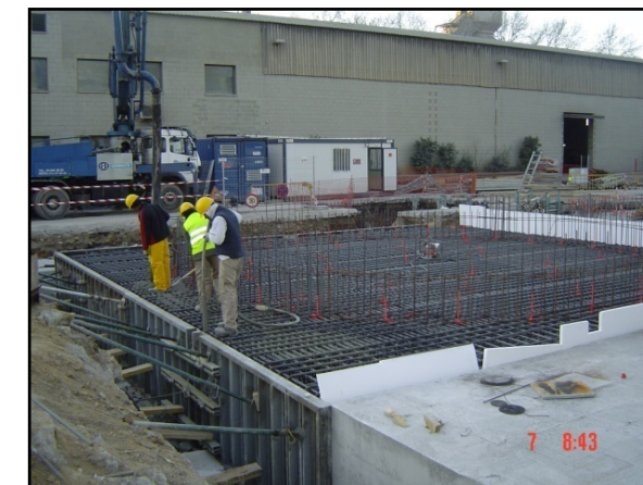
Procés d'encofrat i formigonat amb bomba
