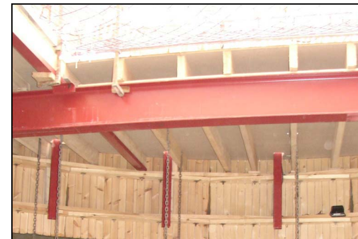
Suports exteriors i interiors de la plataforma de treball
