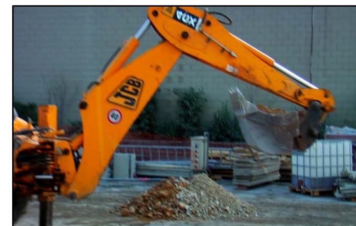
Moviment de terres a l'interior de l'obra
