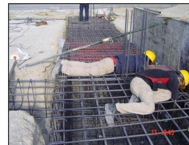
Fonamentació de l'edifici de control preparada per a formigonar
