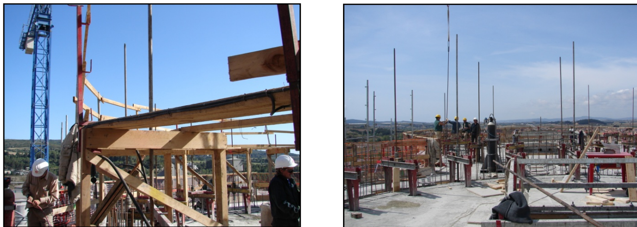
Extracció de la plataforma superior i de les barres de trepa
