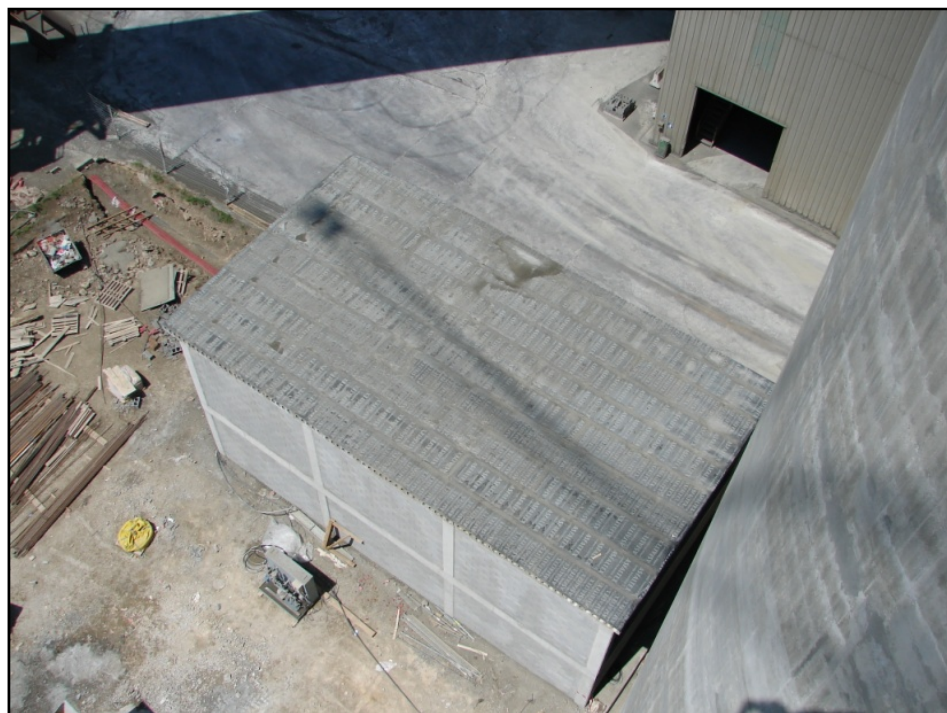
Vista de la impermeabilització de la coberta
