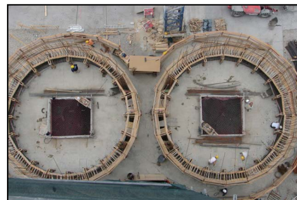
Encofrat preparat per a iniciar el lliscat
