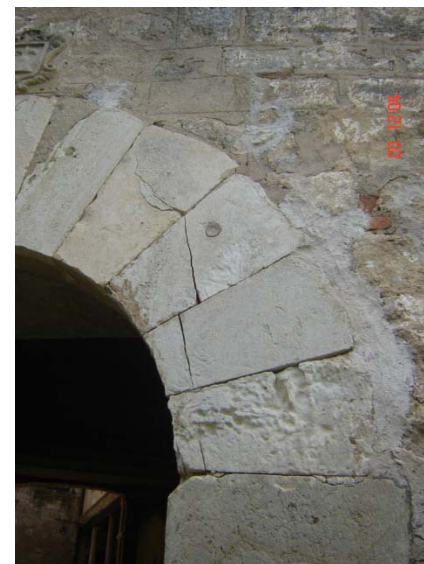
Imágenes de las grietas formadas en los dinteles de las puertas del garaje (primera) y del pasaje (segunda).
