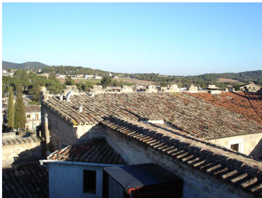
Fotografía donde se puede apreciar el buen estado de las tejas de la cubierta debido a las reparaciones realizadas en años anteriores
