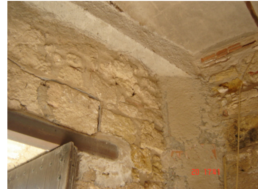
Imagen del refuerzo del hormigón armado su correspondiente pilar realizado por la parte interior de la fachada oeste (pasaje) para soportar las cargas superiores.
