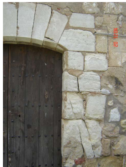
Imágenes de las grietas formadas en los dinteles de las puertas del garaje (primera) y del pasaje (segunda).
