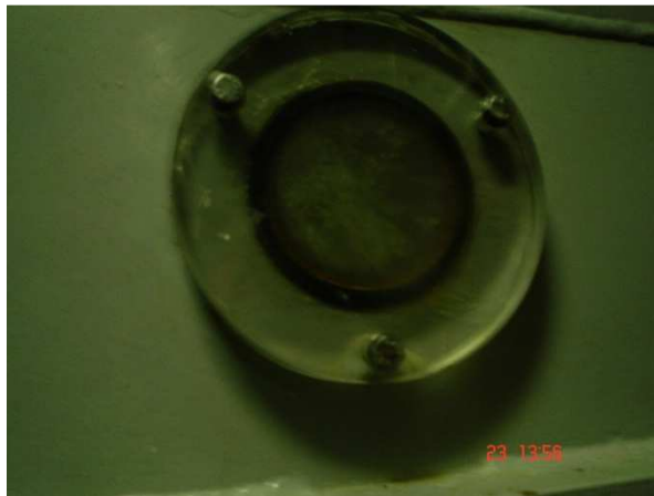
Fig. 24: Mirilla del evaporador
