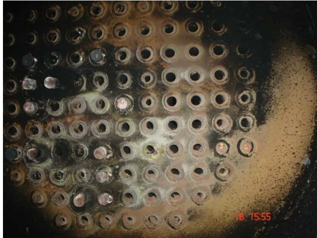
Fig. 35: Tubos taponados mediante soldadura en la reparación del “Suar Vigo”
