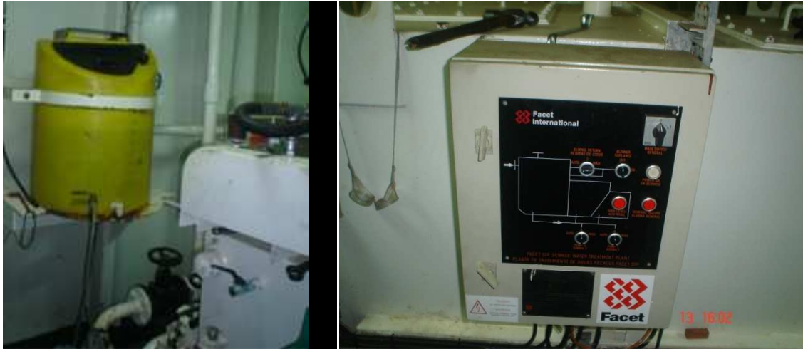
Fig. 34: Tanque del hipoclorito y panel de control de la planta séptica de abordo
