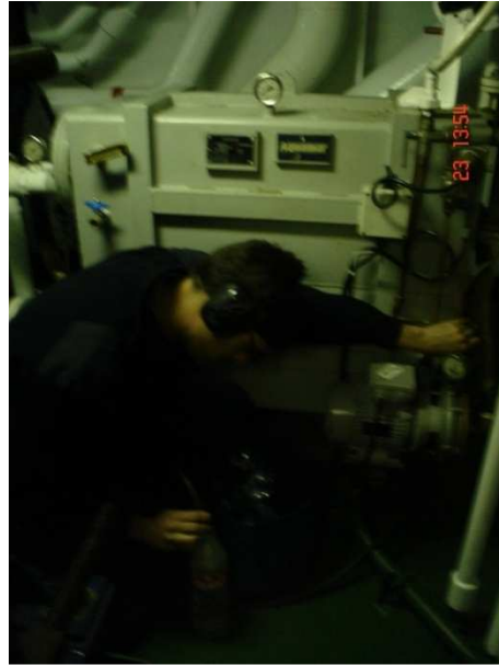
Fig. 25: Recogiendo una muestra de agua del evaporador para su posterior análisis
