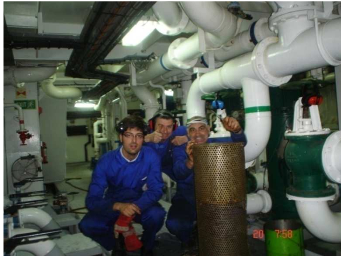
Fig. 5: Limpiando una de las tomas de mar
