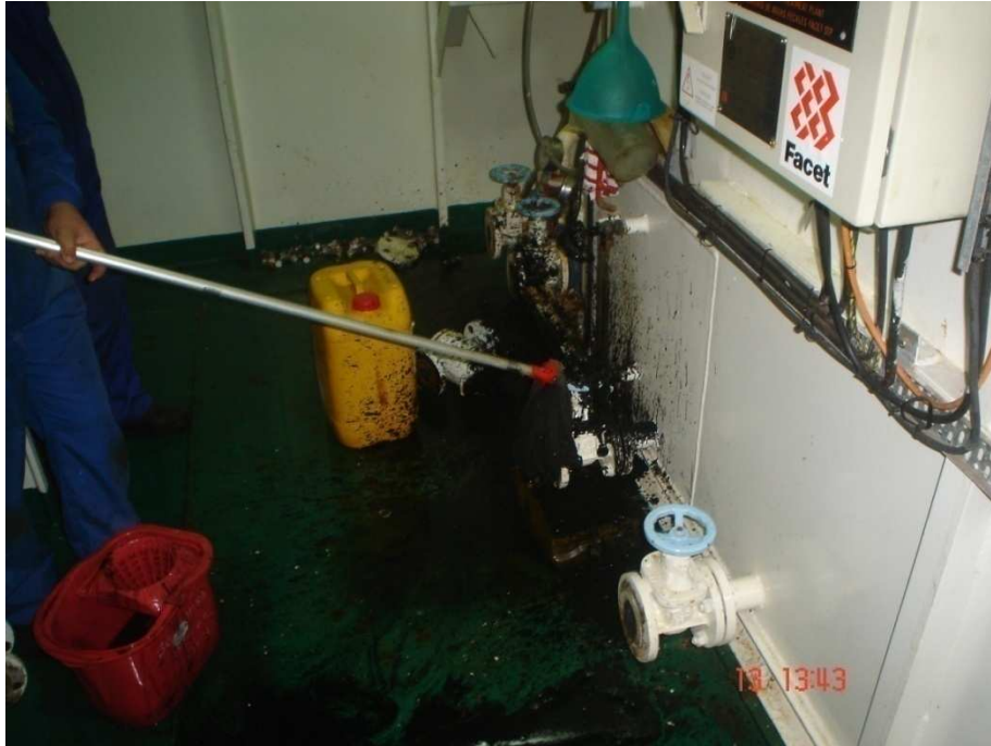
Fig. 33: Limpieza del local de la planta séptica después de una reparación
