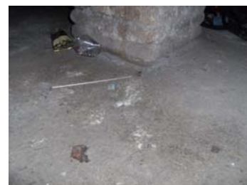
Paviment local 2 i 3
