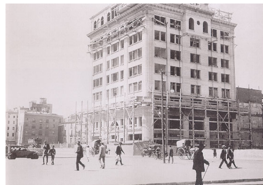
Obres de la Casa Cambó.
