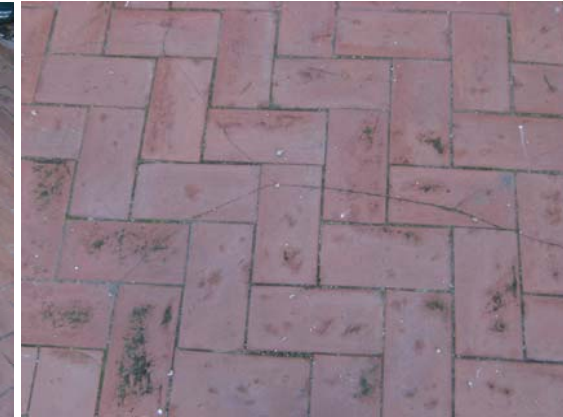
Fissures al paviment de la coberta.
