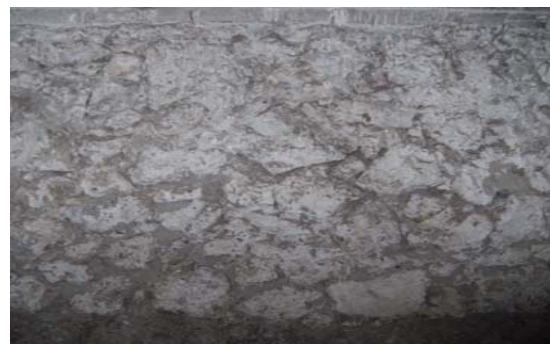
Mur de contenció de maçoneria
