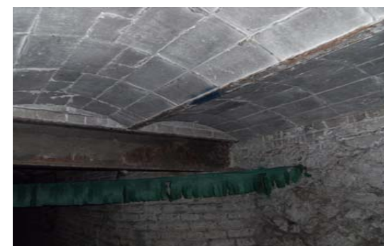
Forjat de biguetes metàl·liques
