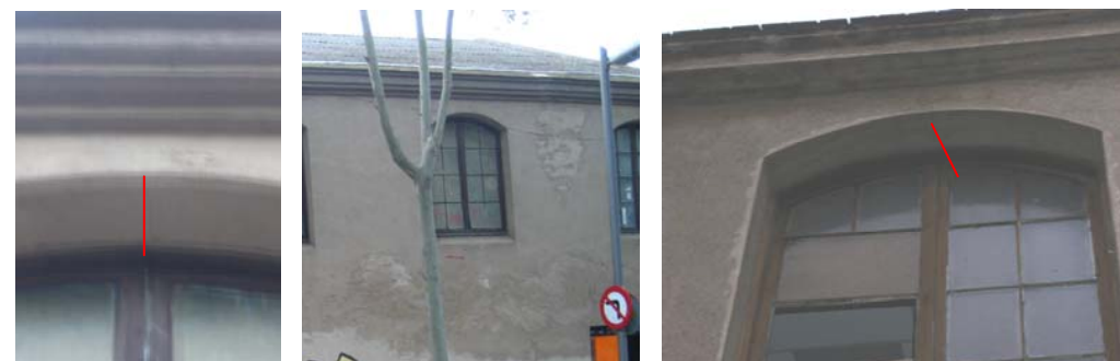
Fissura al centre de l'arc de la finestra.
