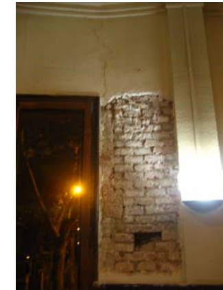
Paret façana de totxo
