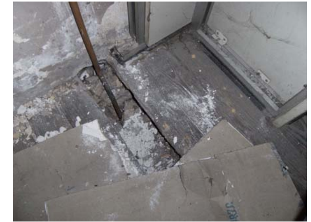
Cala del paviment del teatre
