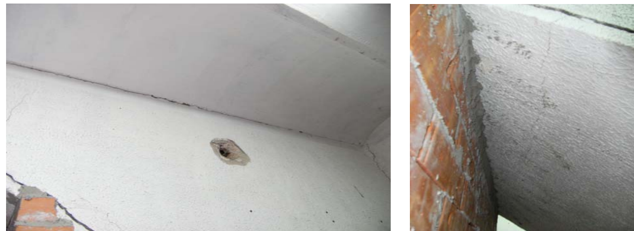
Esquerdes al nivell de la llosa d'escala
