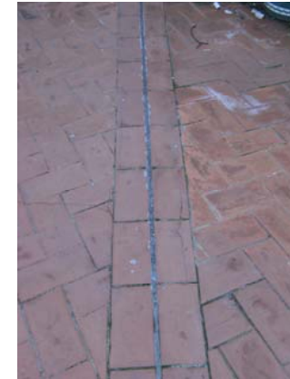
Fissures al paviment de la coberta.
