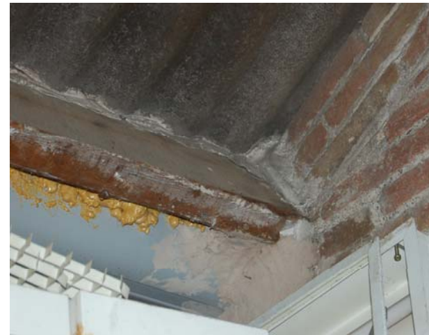
Entrega de la coberta amb el canaló
