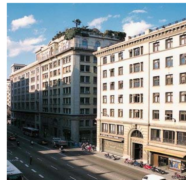
Vista Via Laietana nº 28 i 30.
