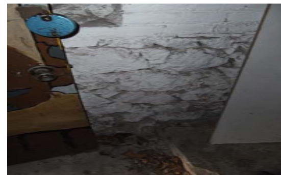
Parament façana interior
