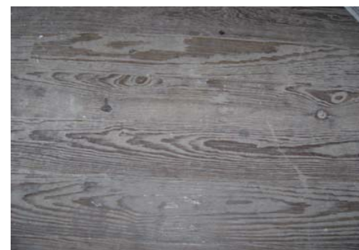
Paviment del teatre
