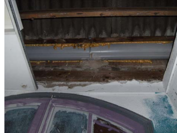
CALA TROBAMENT FAÇANA - COBERTA
