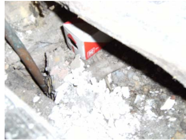
CALA PAVIMENT TEATRE
