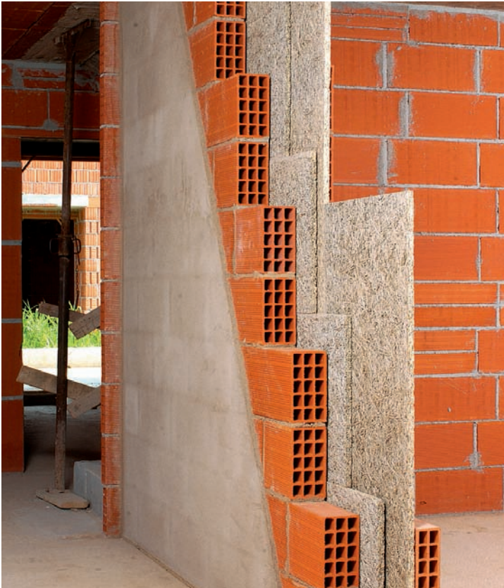
La separación entre paredes debe ser ligeramente superior al espesor del panel, para que éste pueda vibrar.
