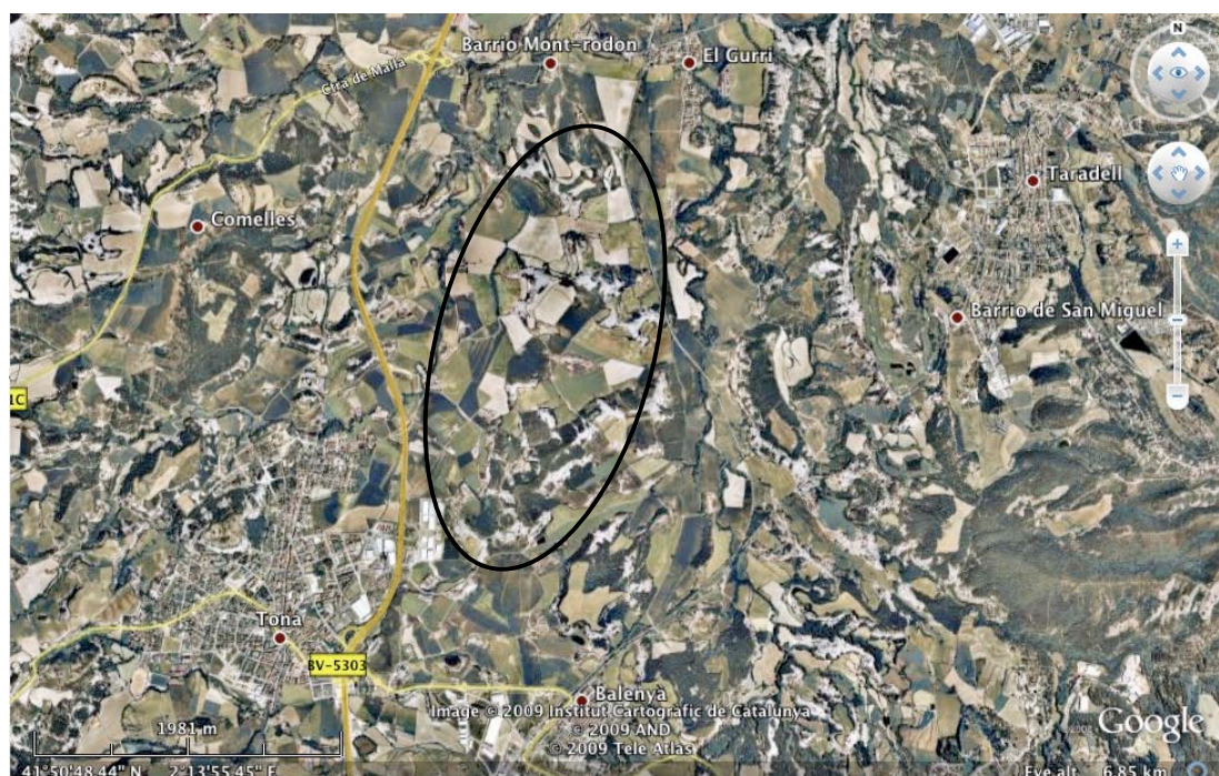
Fig. 2.5.3. Vista aérea de la zona seleccionada para el aeropuerto
