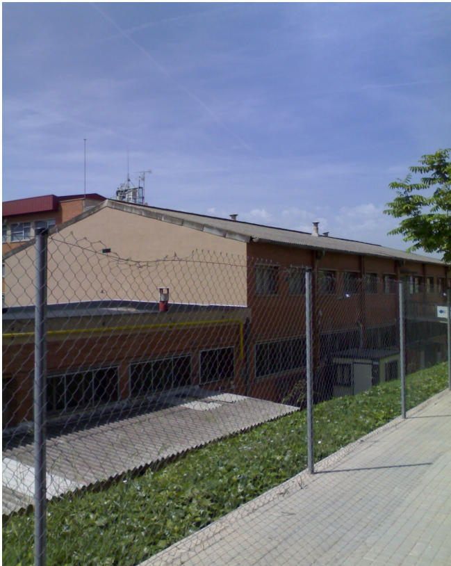
Edifici MN2. Teulada amb inclinació de 15^\circ i teulada sense inclinació.
