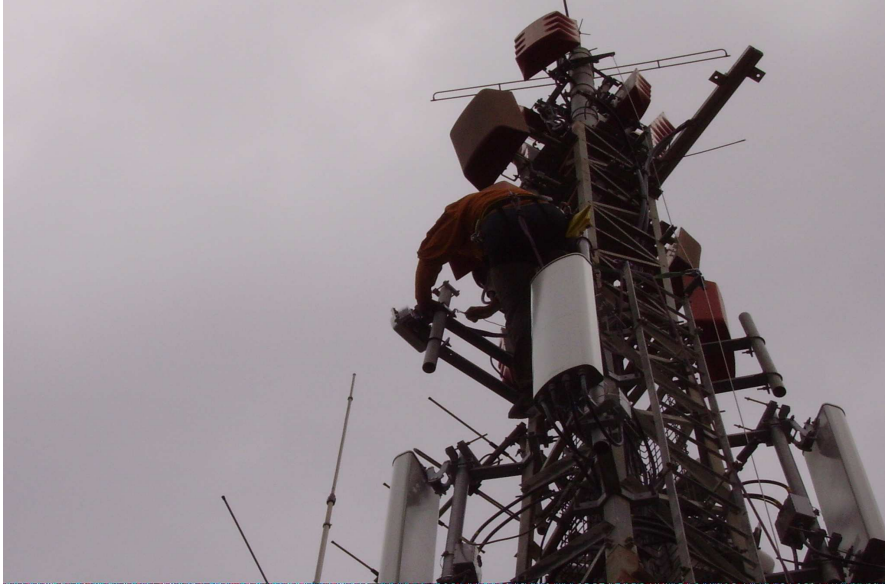
Imatge 22. Tècnic instal·lant l'antena
