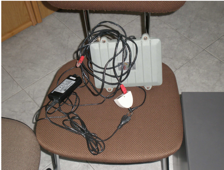
Imatge 32. Punt d'accés amb dispositiu de connexió
