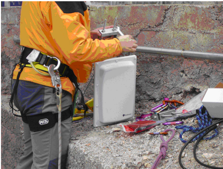
Imatge 1. Antena RN-900 abans de la instal·lació
