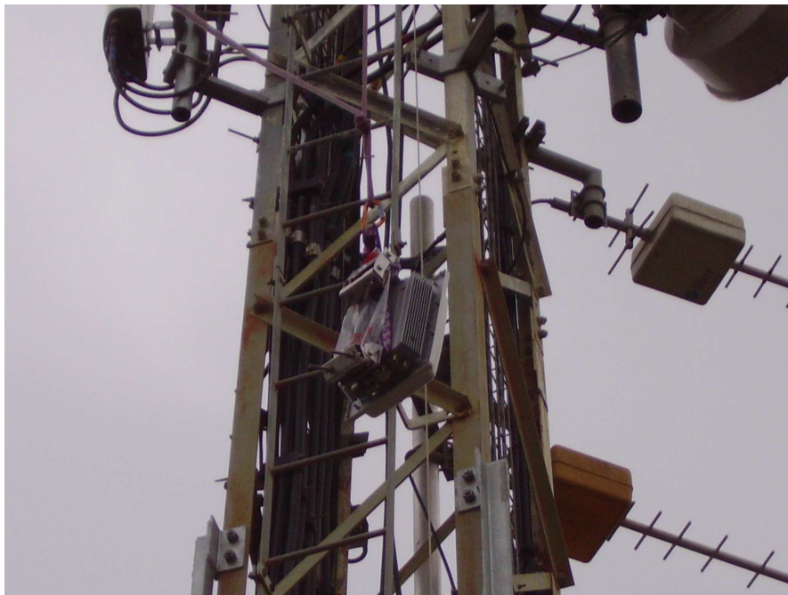
Imatge 21. Pujada de l'antena RN-900
