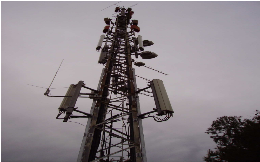
Imatge 18. Mastell per instal·lar l'antena RN-900
