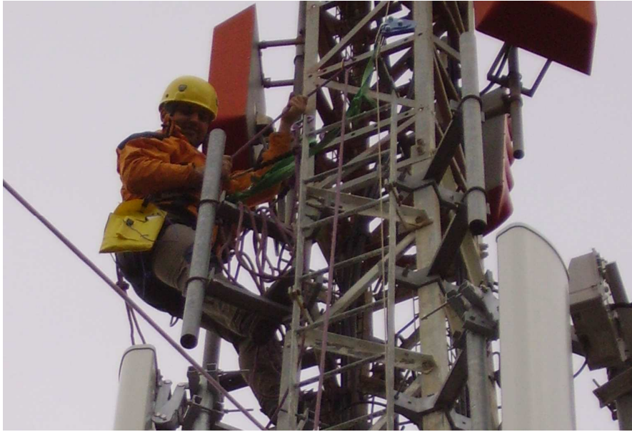
Imatge 20. Instal·lador pujant al mastell
