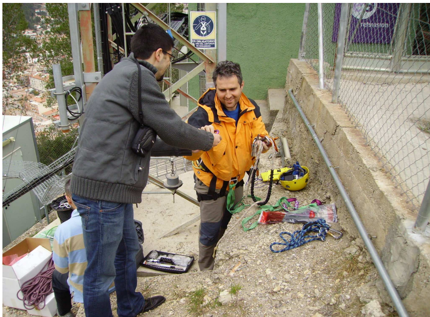
Imatge 19. Ajudant en la instal·lació
