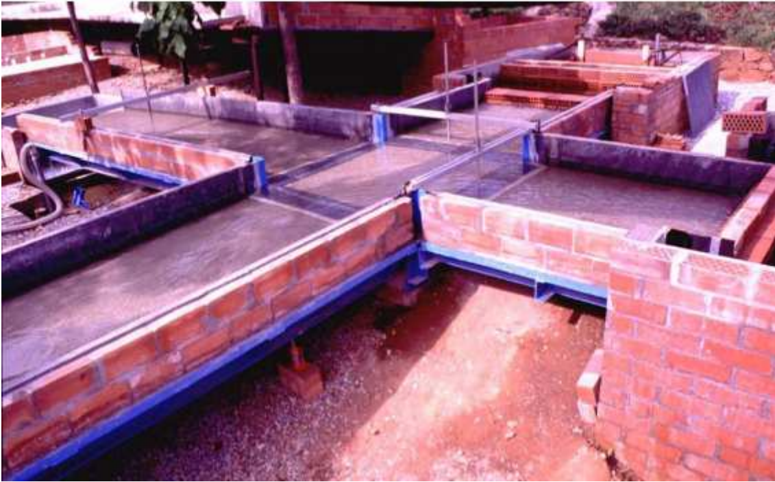
Figura 5: Fotografía del dispositivo experimental construido en el laboratorio de modelos reducidos de la U.P.C.
