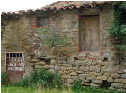
Maons per regularitzar els laterals d'una obertura i diferents trossos col·locats a la façana oest
