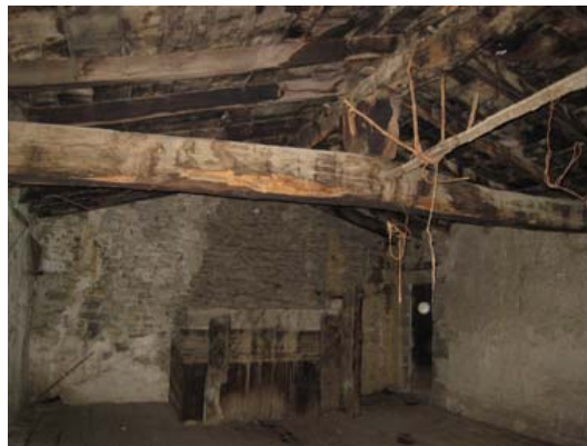
Vista de les jàsseres a la P2_Sala, sota coberta
