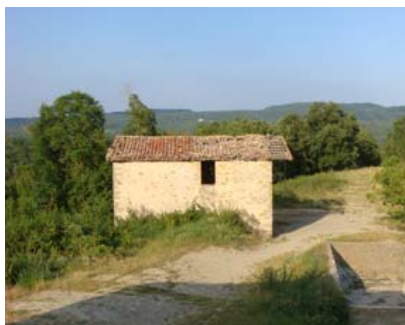
Façana oest de la pallissa
