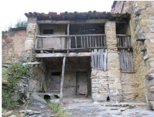
Vista del pilar a la balconada – Façana sud
