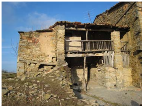
Balconada construïda durant el segle XIX a la façana sud
