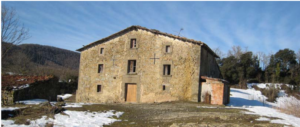
Façana principal de la masia l'Om de Pruit (ORIENTACIÓ EST)
