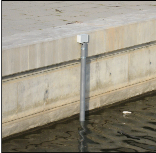
Fig. 1.12 Node sensor muntat sobre el mur de l'estany del campus del Baix Llobregat
