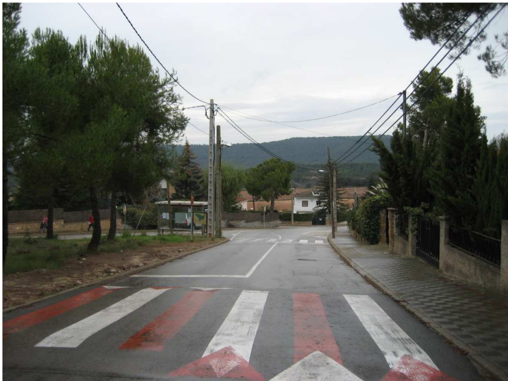
Fotografía 14. Tramo CR-3 (travesía urbanización El Serrat) [fotografía cedida por Diputación de Barcelona 17/11/2010]
