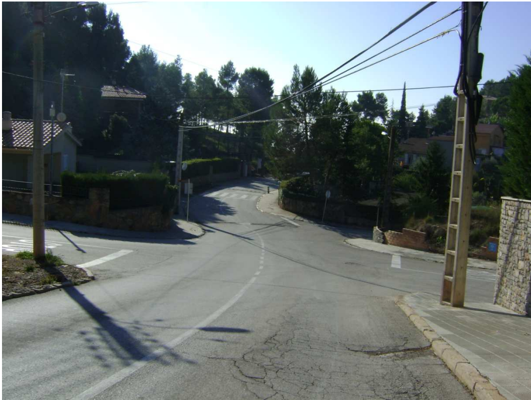
Fotografía 13. Tramo CR-3 (travesía urbanización El Serrat) [elaboración propia 24/10/2012]
