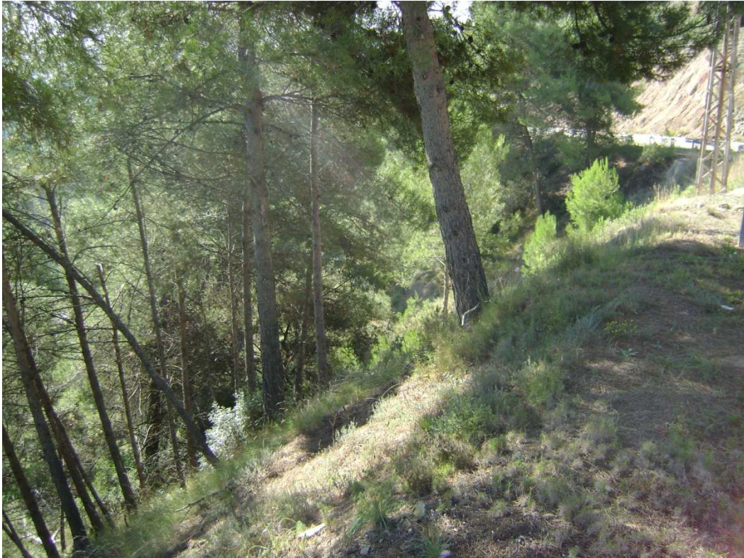
Fotografía 09. Tramo CR-2. Gran pendiente en el talud del tramo CR-2 [elaboración propia 24/10/2012]
