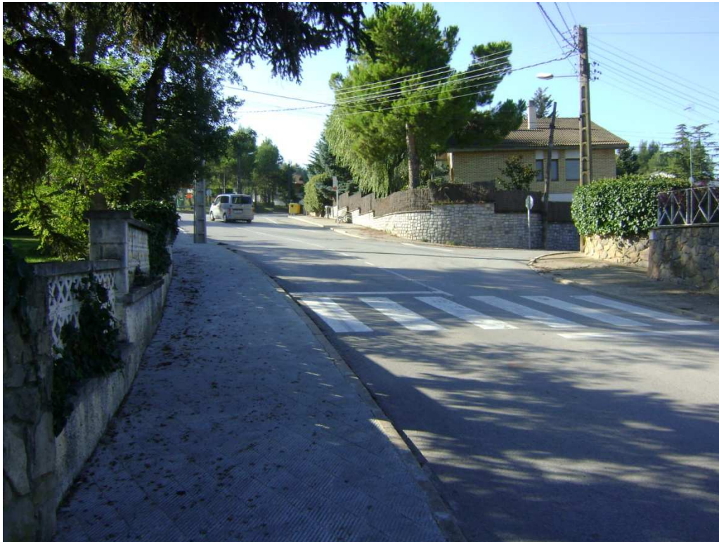
Fotografía 15. Tramo CR-3 (travesía urbanización El Serrat) [elaboración propia 24/10/2012]
