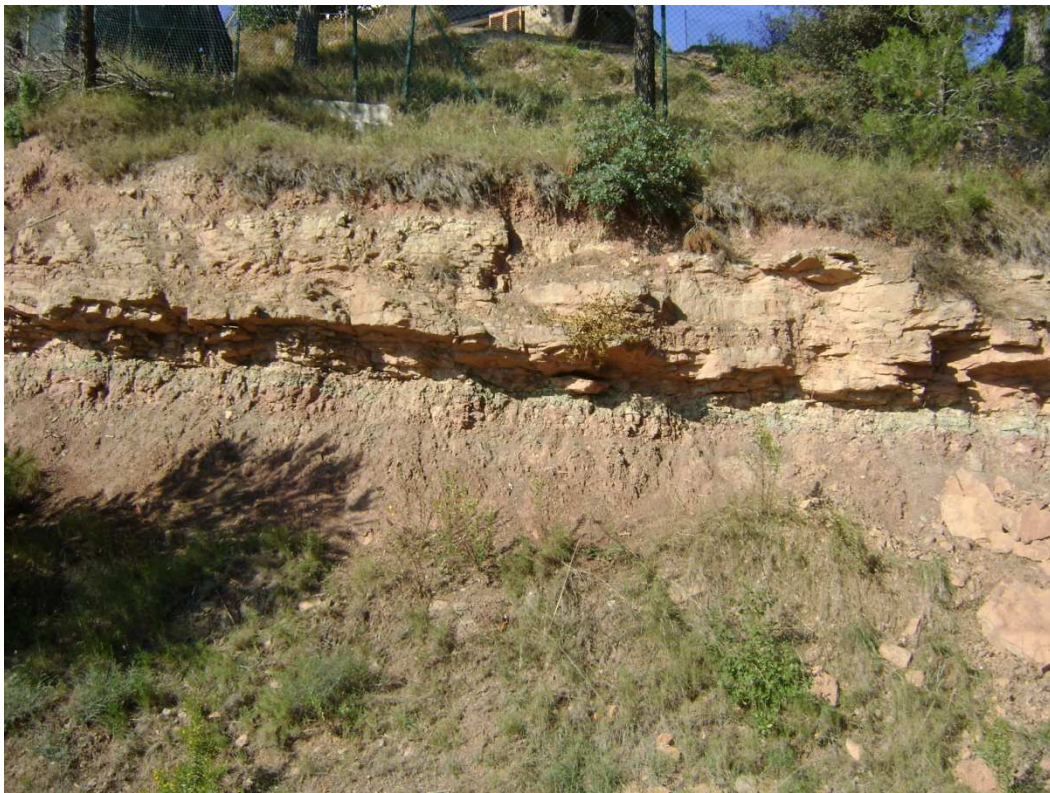
Fotografía 11. Desmorte en el tramo CR-2 [elaboración propia 24/10/2012]
