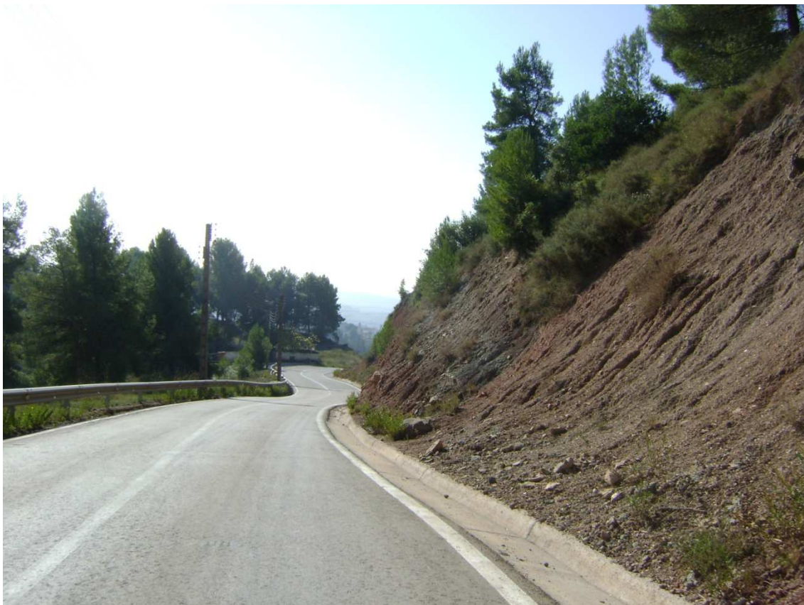
Fotografía 08. Tramo CR-2. [elaboración propia 24/10/2012]
