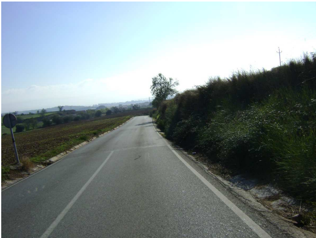
Fotografía 04. Extremo norte del tramo sur. Extremo sur del tramo CR. Esta toma refleja la transición entre el tramo reformado entre 2004 y 2006 y el camino. [elaboración propia 24/10/2012]
