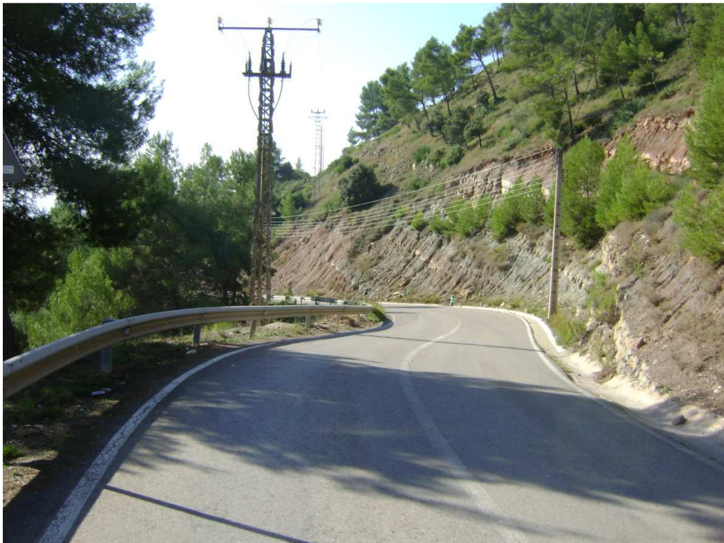
Fotografía 10. Transición entre tramo CR-2 y tramo CR-3 [elaboración propia 24/10/2012]
