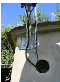
Accés a l'interior de la caseta
