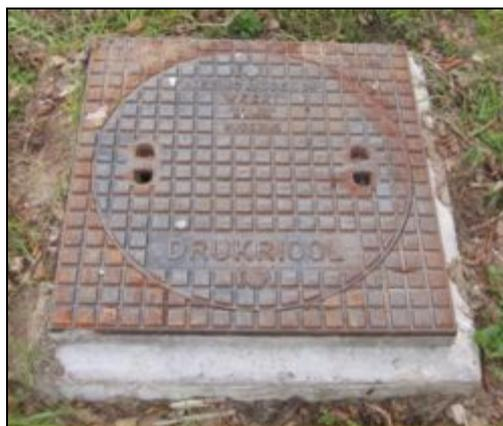
Figura 125 Placa de registro de una alcantarilla. Fuente: SanMat
