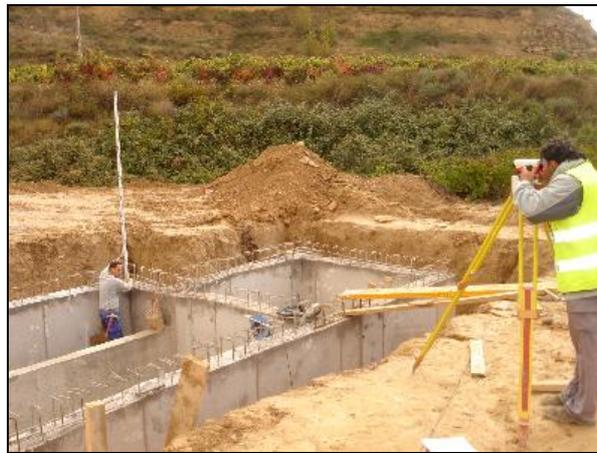
Figura 123 Construcción fosa séptica in-situ Fuente: J. Pérez 09
