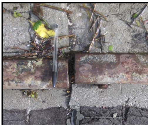
Figura 4.12 - Desajuste del riel de San Esteban
