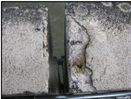
Figura 4.16 - Vista aérea del movimiento relativo entre bloques
