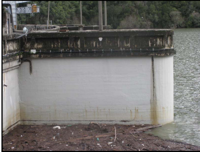
Figura 5.9.- Estado actual del paramento impermeabilizado en San Esteban
