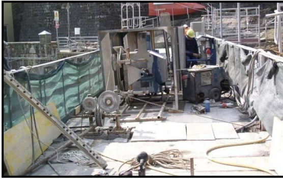
Figura 5.18- Maquinaria necesaria en coronación para efectuar el corte. (Marcello et al., 2006)
