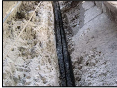
Figura 5.19-. Junta reabierto con un corte (Marcello et al., 2006)
