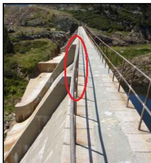
Figura 4.13- Barandilla curvada en la presa de Rumedo
