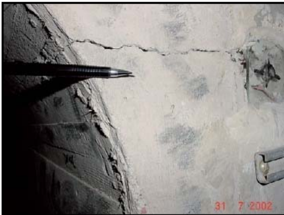
Figura 5.30- Fisura de la galería superior Figura 5.31-Esquema de la fisura anterior (Amberg, 2007).
