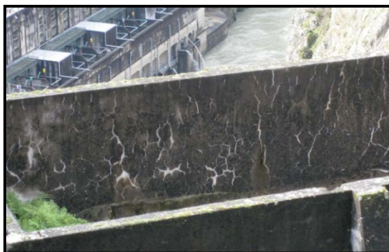
Figura 4.1- Fisuración mapeada
