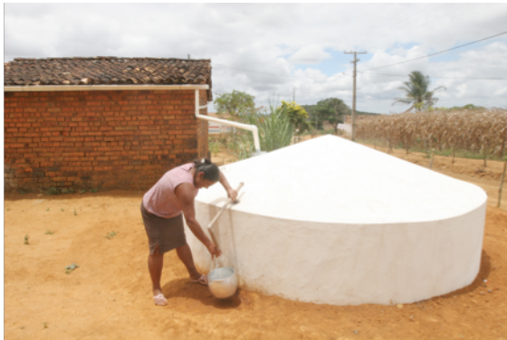
Figura 17: Cisterna de captación de agua pluvial. Fuente: http://www.fomezero.gov.br
