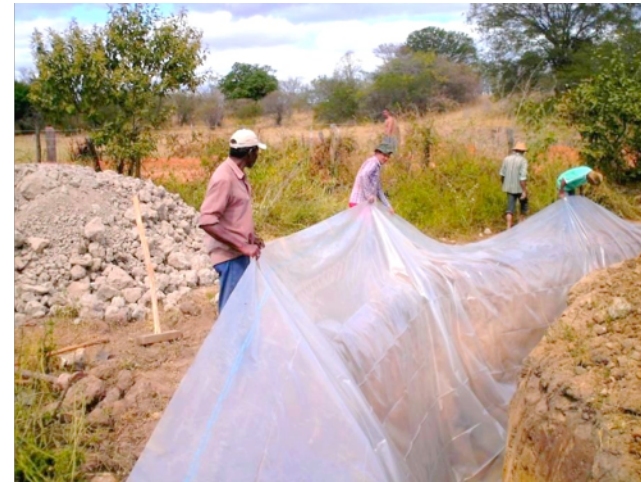
Figura 18: Construcción de una presa subterránea. Fuente: http://2.bp.blogspot.com
