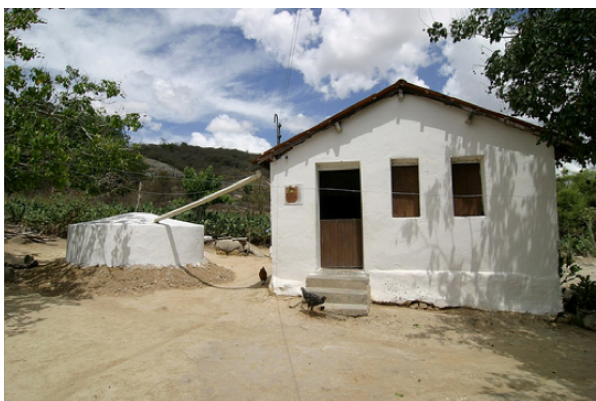
Figura 28: Cisterna de placas instalada Fuente: http://farm3.static.flickr.com
