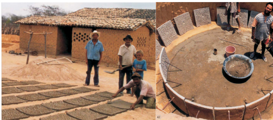
Figura 29: Montaje de las placas para las paredes de la cisterna. Fuente: http://www.cliquesemiarido.org.br/inicial.asp
