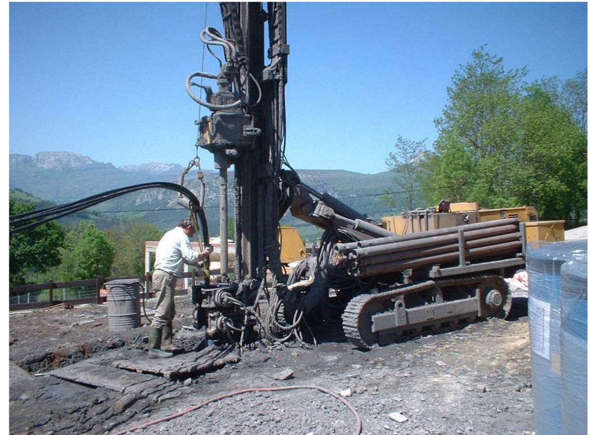
Máquina perforadora realizando la perforación para pozos geotérmicos
