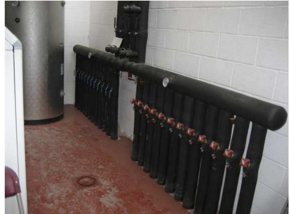
Imagen de las salidas hacia los pozos o colectores geotérmicos
