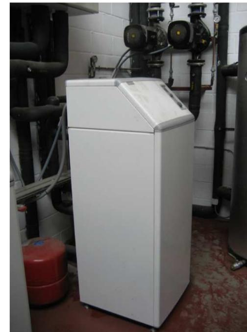
Bomba de calor geotérmica
