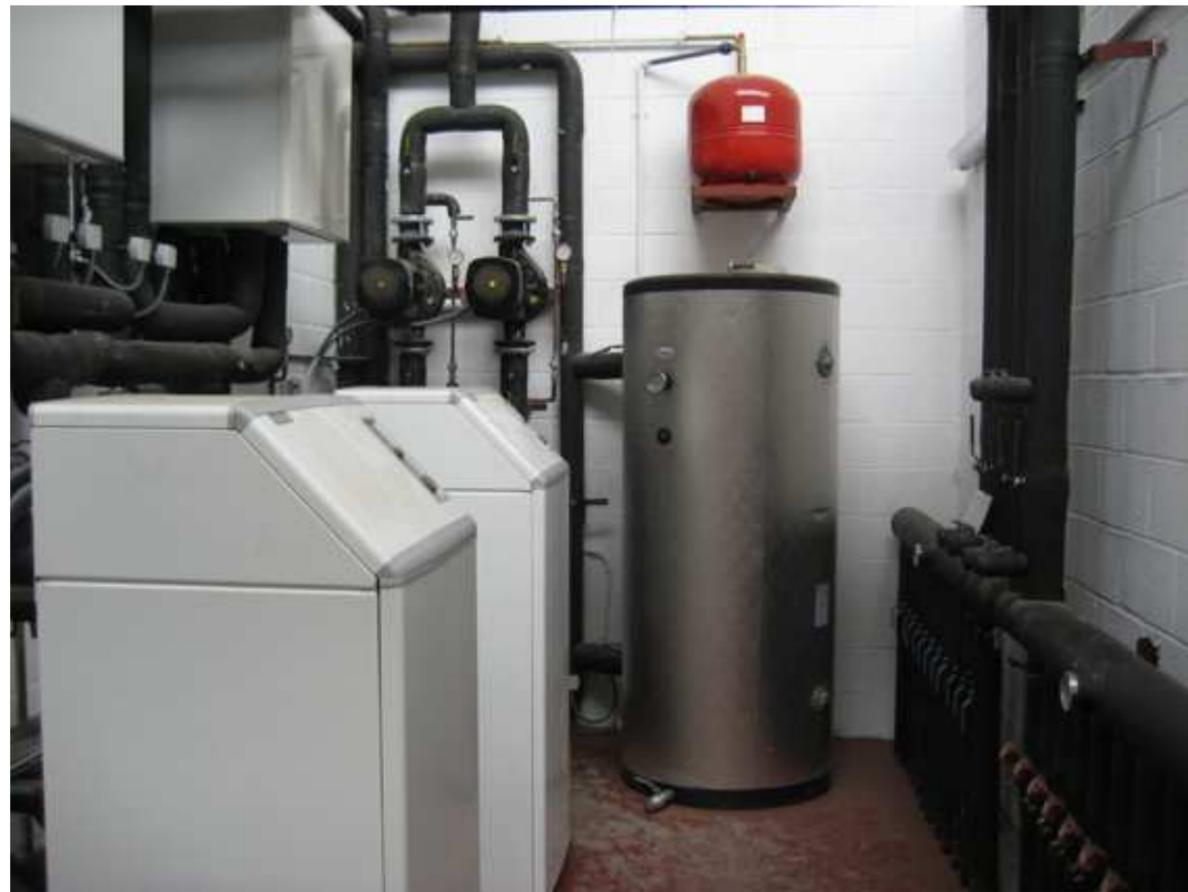
Imagen de la sala de máquinas donde podemos ver las bombas de calor, un depósito de inercia y un vaso de expansión, entre otros elementos
