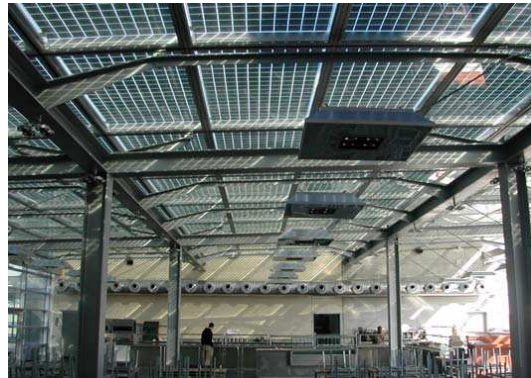
INTEGRADO: CUBIERTA SEMITRANSARENTE
