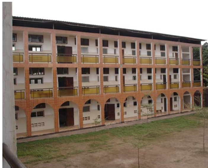
Fig. 4.2 Edifici sud del CFP de la Salle a Conakry
