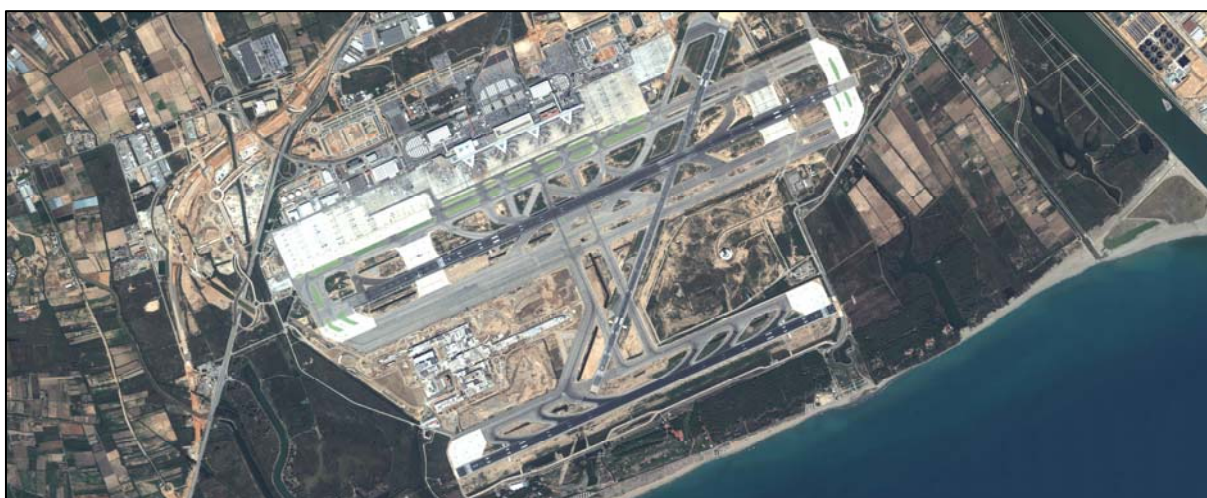
Figura 8.13: Ortofoto de l'aeroport de Barcelona en vol del 2006 on s'aprecia l'estat actual de les principals actuacions del Pla Barcelona d'AENA.
