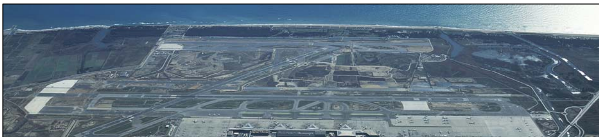
Figura 5.4: Foto aèria obliqua de l'Aeroport de Barcelona (gener 2004).
