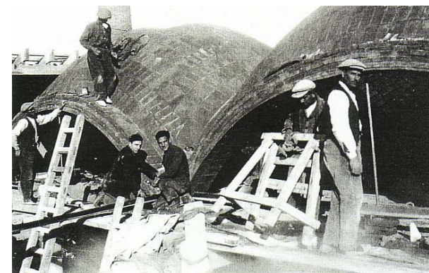
Construcció d'una de les voltes de la quadra del Vapor Amat sota la direcció de Joan Baca i Reixach (1931)
