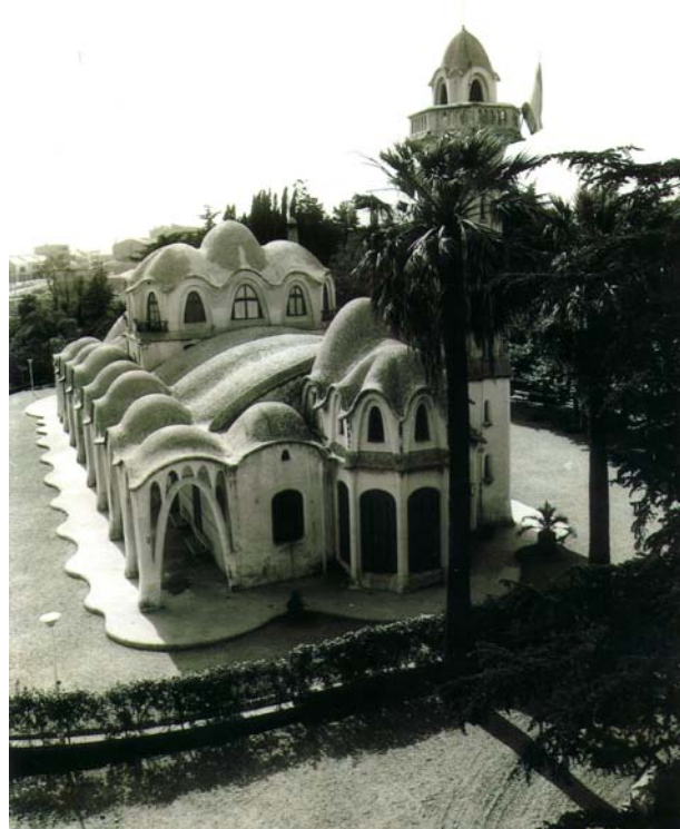
Fotografia on s'entreveu la masia ja acabada amb el cos nou adjuntat i la torre finalitzada.
