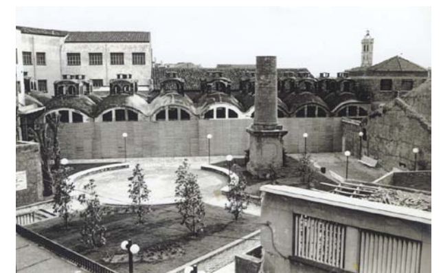
Vista general de la primera plaça Didó després de l'esponjament
