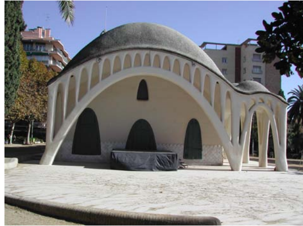
Porxo façana oest tancat per dos arcs parabòlics de diferent tamany
