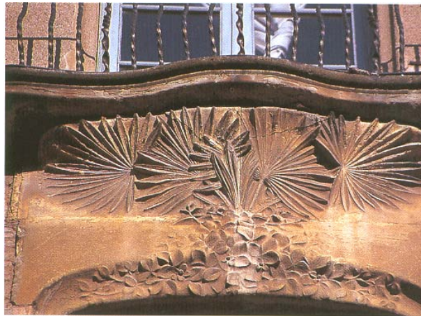
Detall de façana d'Hotel Peninsular (1903) Arxiu Lunweg - Teresa Llordés
