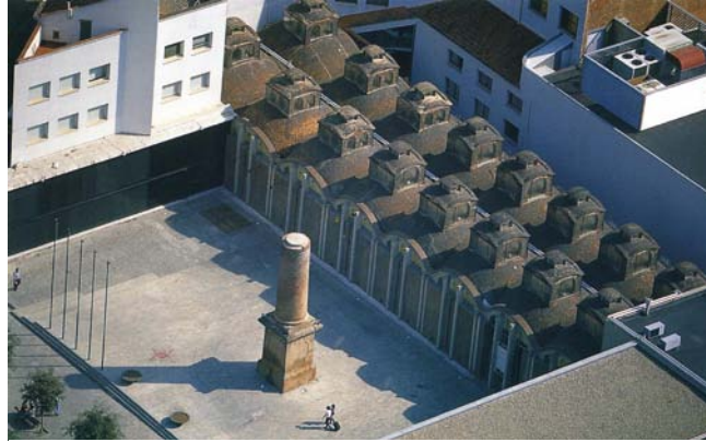
Visió general del conjunt de la sala amb la plaça i la xemeneia integrada en aquesta
