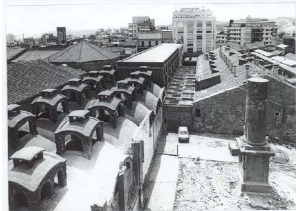
Vista general després de l'enderroc de part de la fàbrica CATEX
