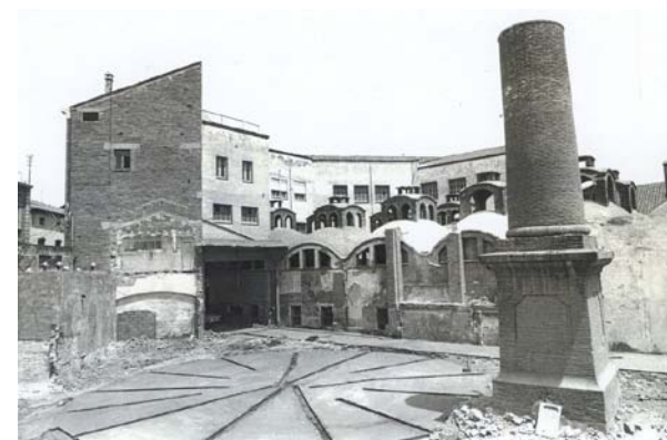
Vista general de la fonamentació de la futura plaça Didó
