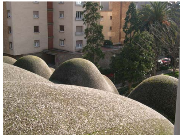
Detall de voltes de cobertura de l'antiga coberta
