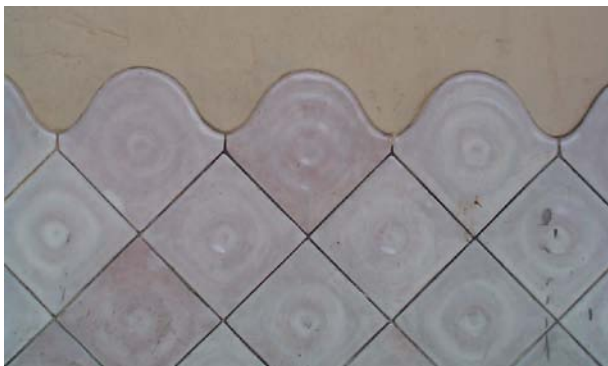
Detalls de l'arrambador ceràmic restaurat
