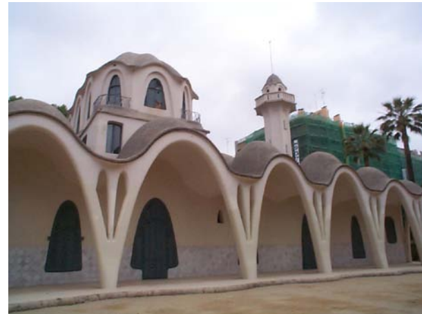
Galeria de la façana Sud formada per arc parabòlics
