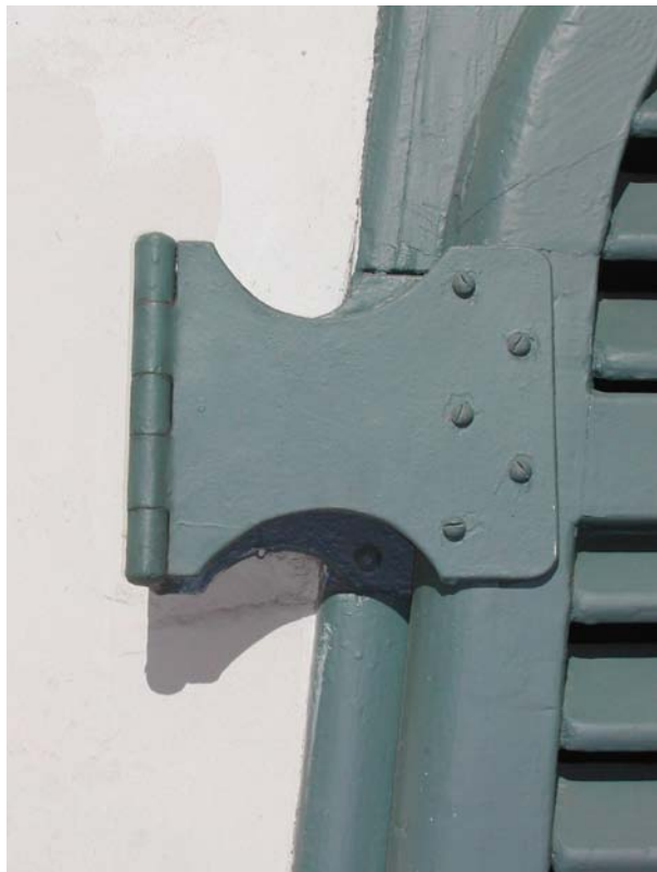
Detall fusteria exterior
