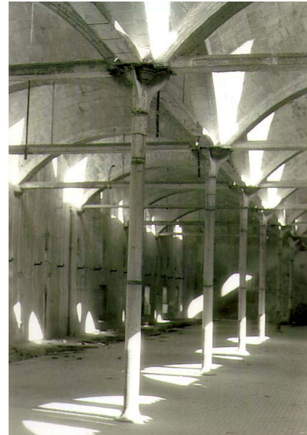
Vista interior de la quadra del Vapor Amat, on destaquen els pilars de fossa (1981)
