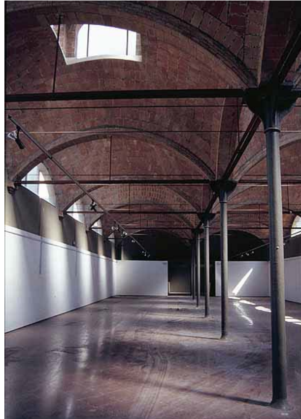
Fotografia que ens mostra la planta lliure de la sala i la seva estructura atirantada
