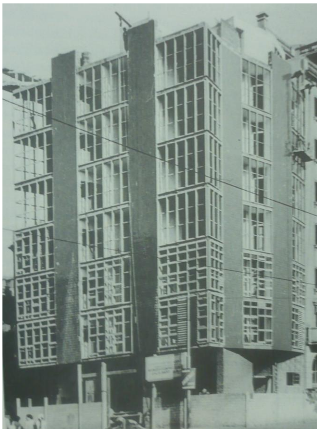
Imatge del edifici en construcció
