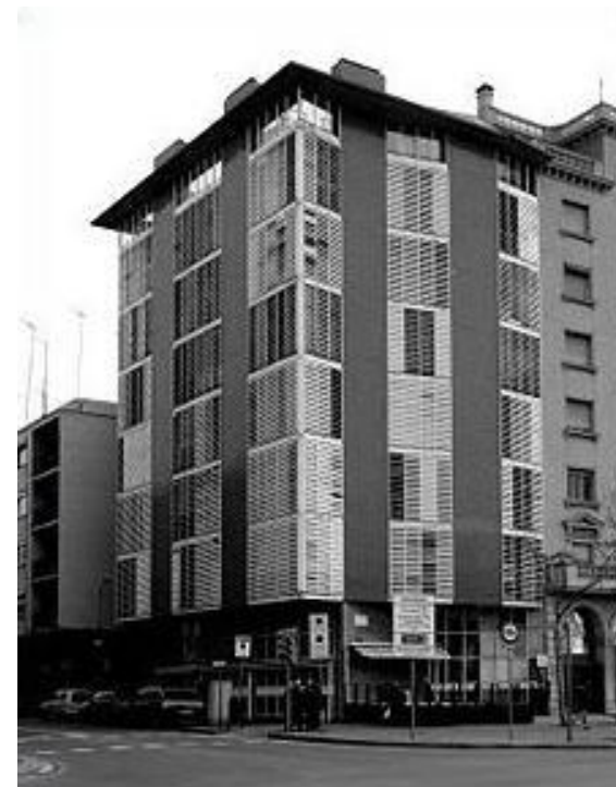
Façana cantonada carrer Almirant Cervera - Carrer del Mar
