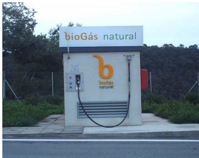
Figura11. Sortidor de biogàs per a la flota de vehicles de l'abocador de Coll Cardús (2006).
