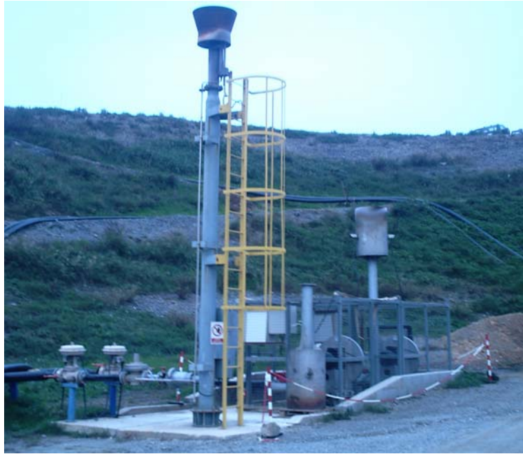
Figura 9. Torxa de seguretat de la planta de biogàs de l'abocador de Coll Cardús (2006).
