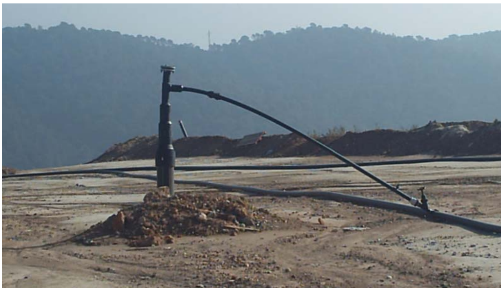
Figura 8. Pous d'extracció de l'abocador de Coll Cardús (2006).
