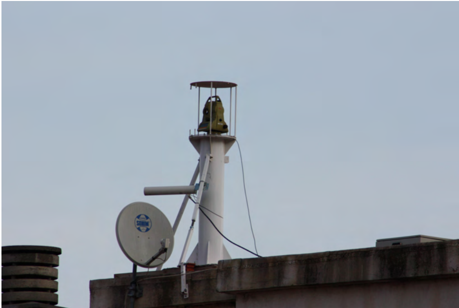
Figura 3.13. Estació automàtica programable instal·lada en un terrat per al control de façanes d'edificis propers.
