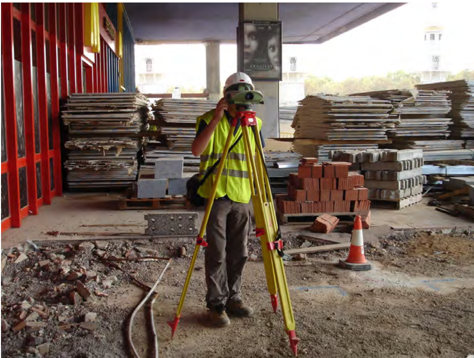
Figura 3.8. Enginyer tècnic en topografia realitzant una anivellació geomètrica d'alta precisió
