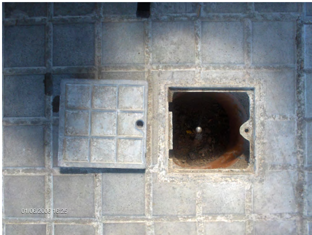
Figura 3.1. Base d'anivellació profunda
