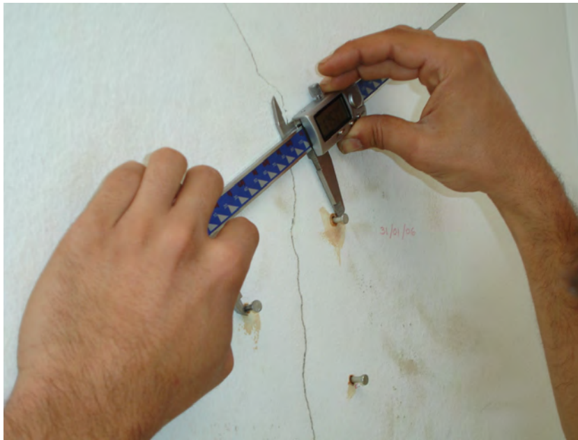
Figura 4.12 Control d'una fissura amb un peu de rei digital
