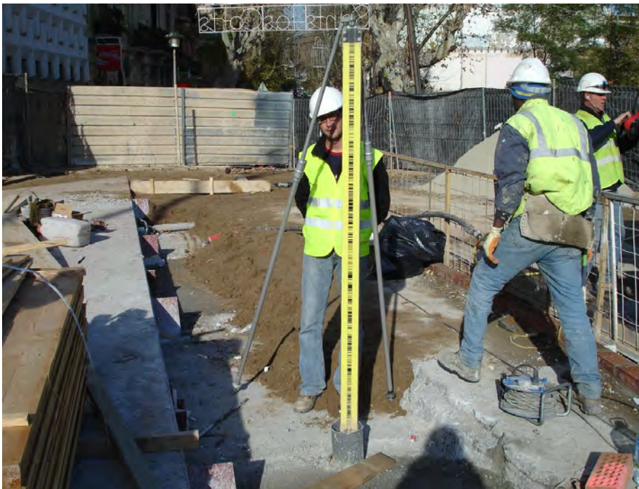
Figura 2.2. Auxiliar de topografia en la presa de dades durant una anivellació geomètrica.
