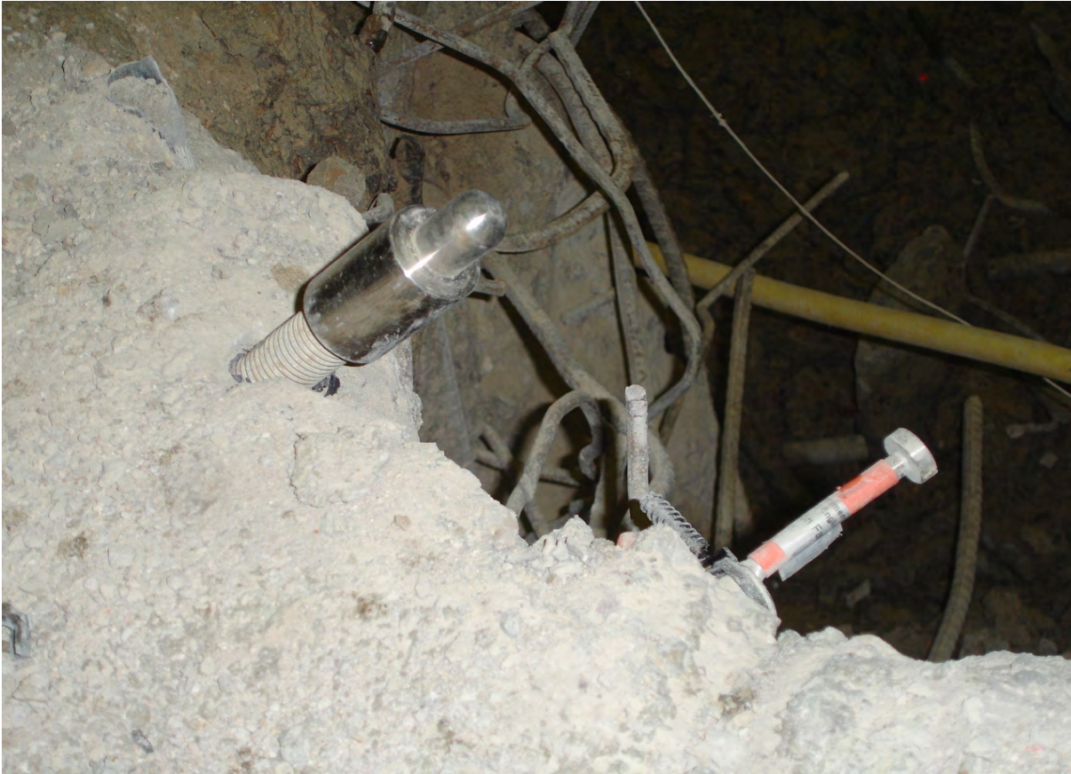
Figura 3.9. Exemple de fita destruïda i no aprofitable.
