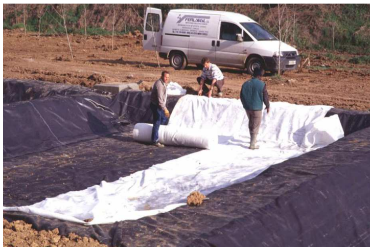
Figura 7. Operacions de col·locació de làmines sintètiques aïllants
