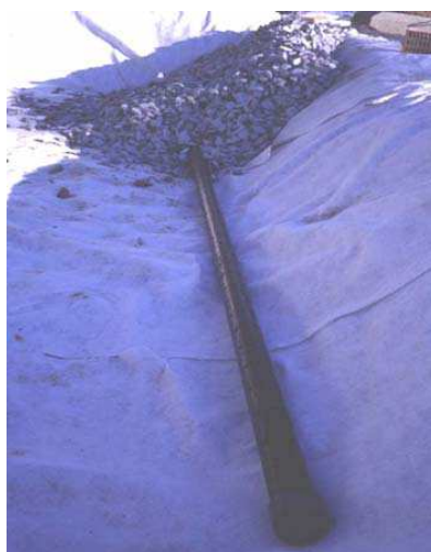
Figura 6. Col·locació del tub de sortida d'un sistema d'aiguamoll subsuperficial
