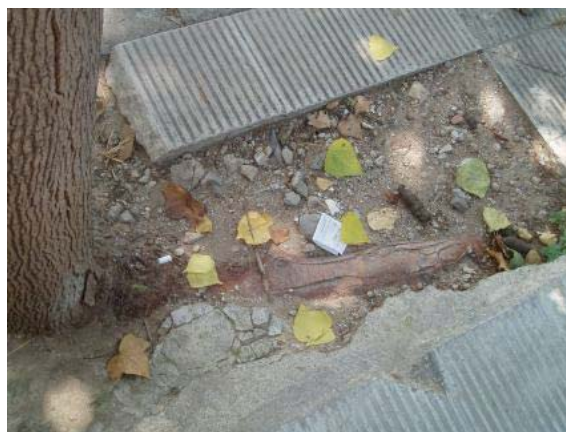
Fig. 21: Panot mal consolidat a l'Av de la Pineda amb Av Catalunya Fig. 22: Capa de morter consolidant del panot deteriorada (C/ Aragó)
