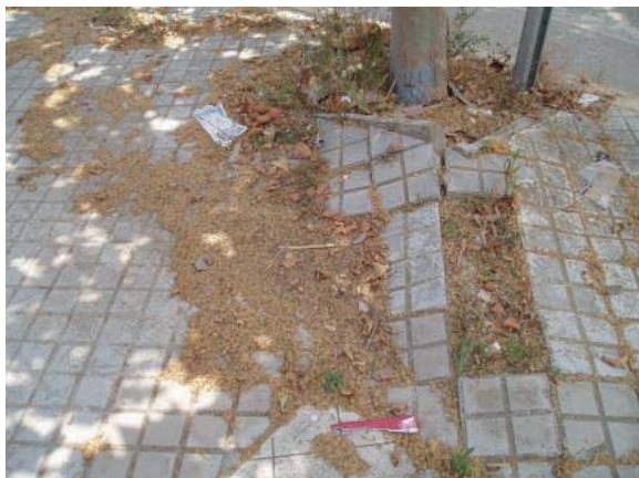
Fig. 21: Panot mal consolidat a l'Av de la Pineda amb Av Catalunya Fig. 22: Capa de morter consolidant del panot deteriorada (C/ Aragó)
