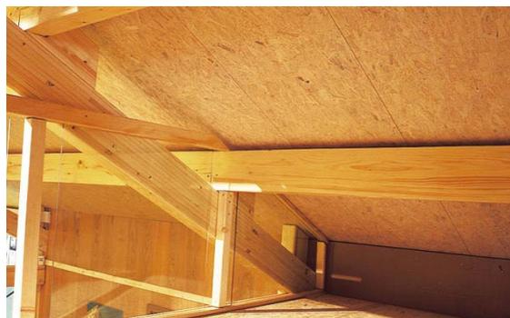
Ilustración 19. Ejemplo de uso del tablero OSB 3 para la construcción de cubiertas.
