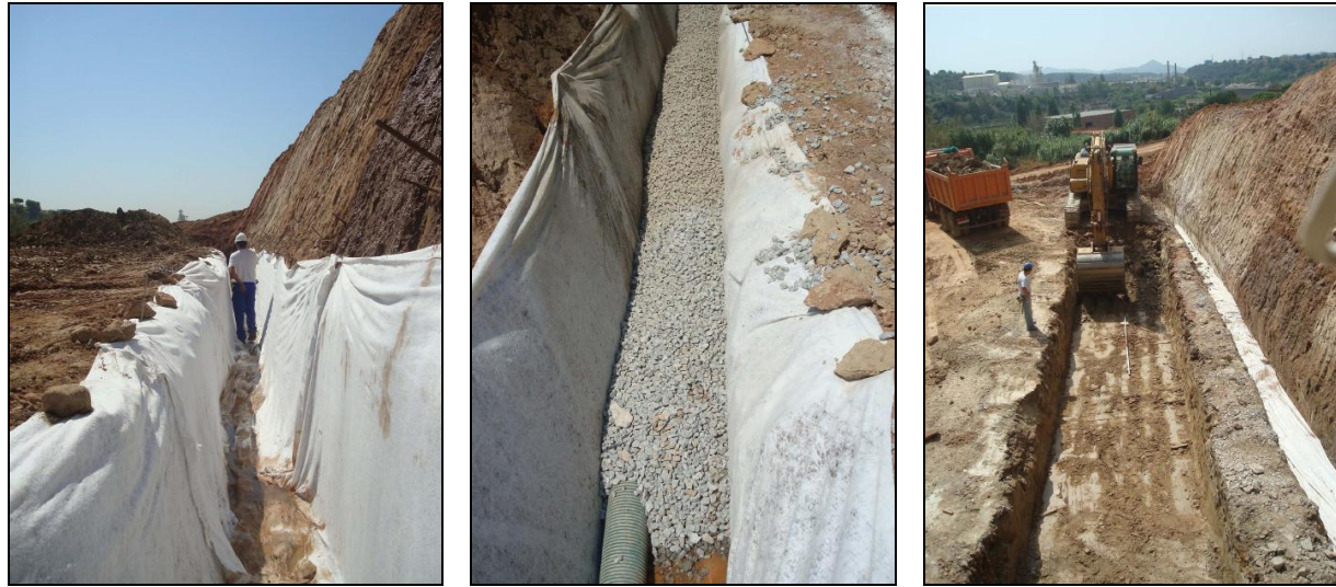
Imatge 5.18: Rasa drenatge protegida amb un geotèxtil.
