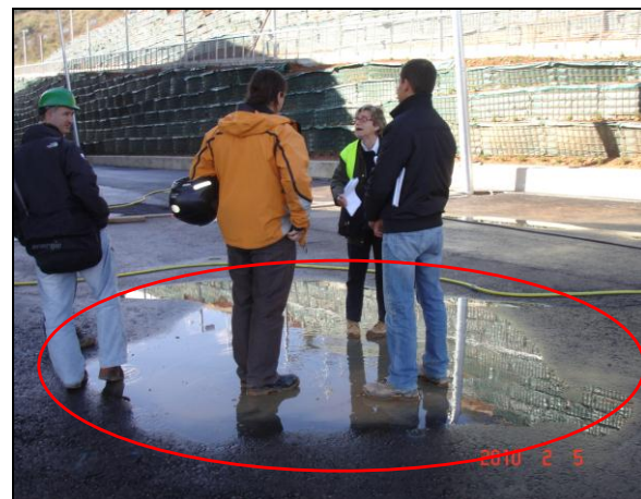
Imatge 5.58: Clots d'aigua explanada accés
