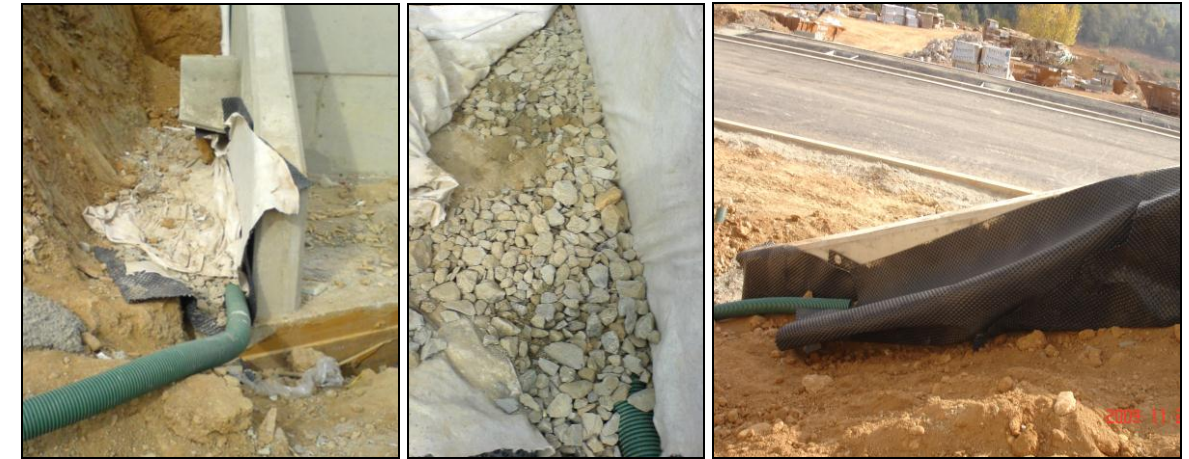
Imatges 5.31: Tub dren darrera del mur embolcallat amb grava i protegit amb un geotèxtil
