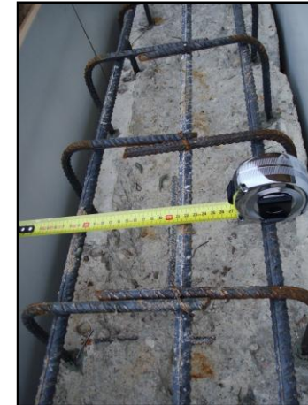
Imatge 5.36: Armadura encastada al mur i fixada amb resines epoxi
