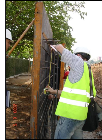
Imatge 5.9: Comprovació de l'armat del mur
