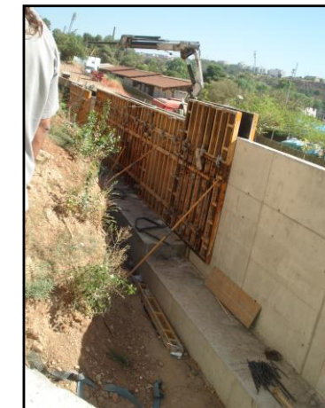
Imatge 5.17: Desencofrat del mur.
