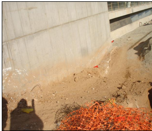
Imatge 5.51: Fonaments del mur de la pista
