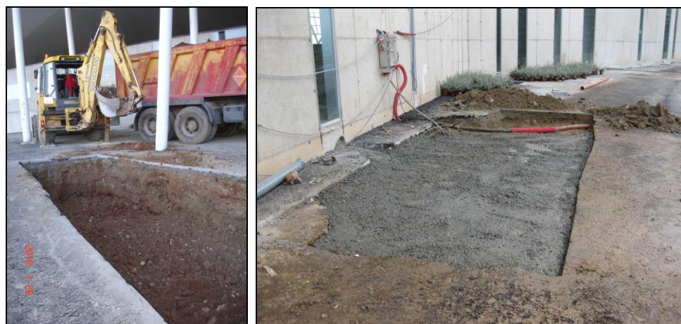
Imatge 5.60: Sanejament de les zones mal compactades.
