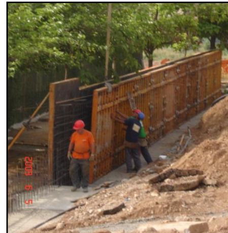
Imatge 5.10: Encofrat del mur
