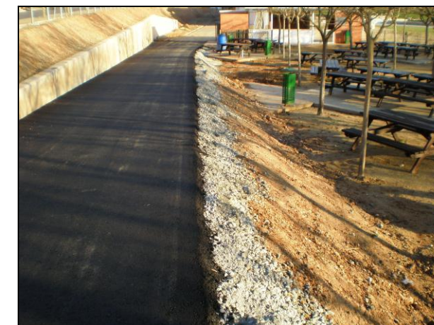
Imatge 8.2: Rampa piscina
