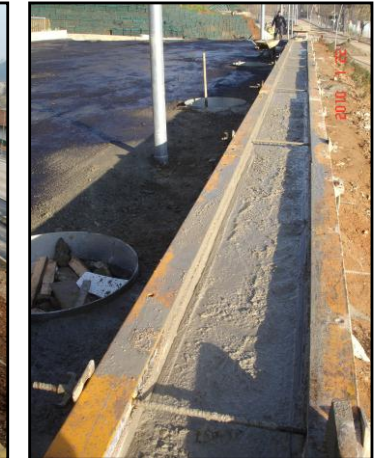
Imatge 5.38: Formigonat del mur.
