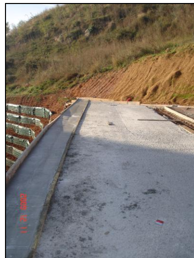
Imatge 5.35: Formigonat de la llosa.
