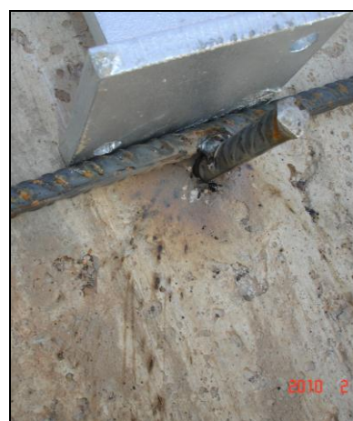
Imatge 5.42: Rodó encastat al mur amb resines epoxi i rodó transversal.
