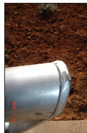
Imatge 8.5: Soldadura barana
