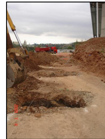
Imatge 5.15: Excavació dels daus de formigó.
