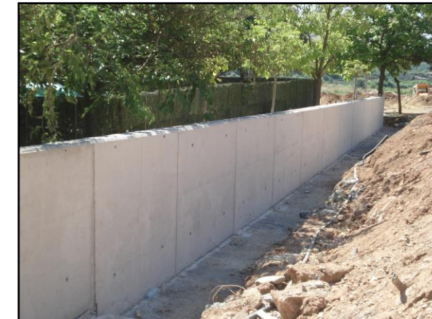
Imatge 5.11: Aspecte final del mur
