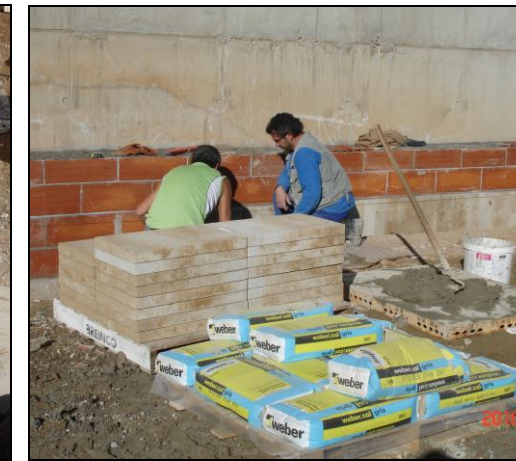
Imatge 5.54: Detall execució banc continuació rampa
