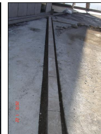
Imatge 5.50: Peça de vorada sobre base de formigó.
