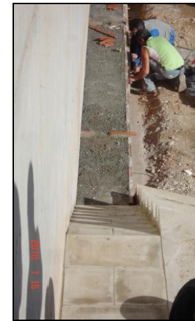
Imatge 5.54: Detall execució banc continuació rampa
