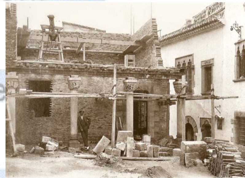
Construcció del porxo, 1915.
