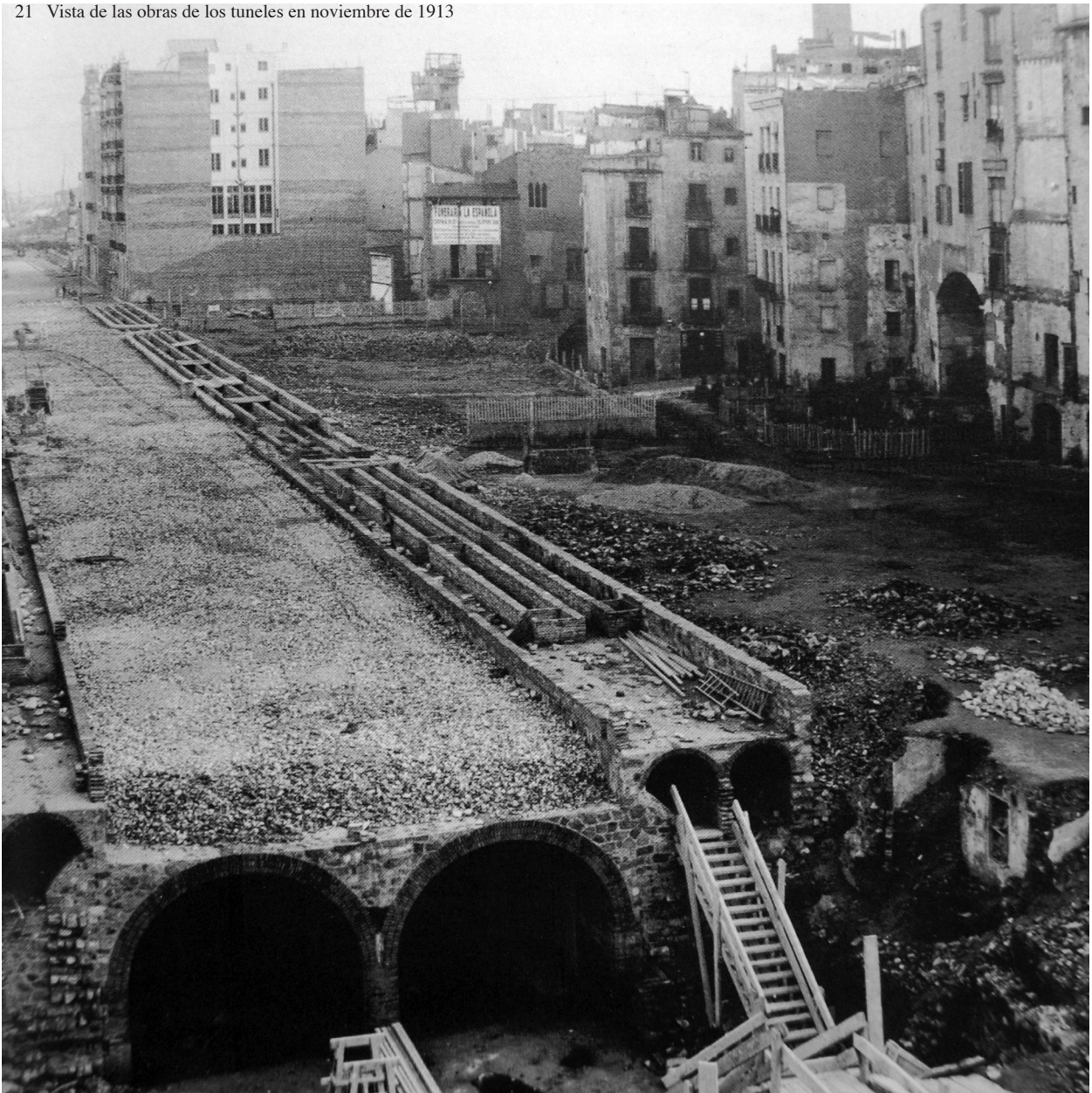
21 Vista de las obras de los tuneles en noviembre de 1913
