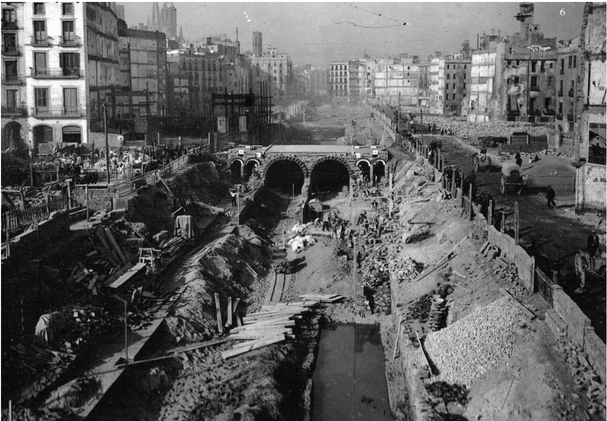
6-7-8-9- Los túneles del futuro metro en noviembre de 1913
