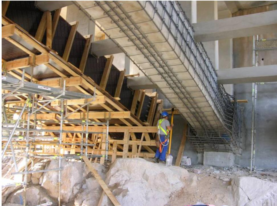
**Figura 16.** Refuerzo con HAC de los arcos de un puente (Velasco, 2008)
