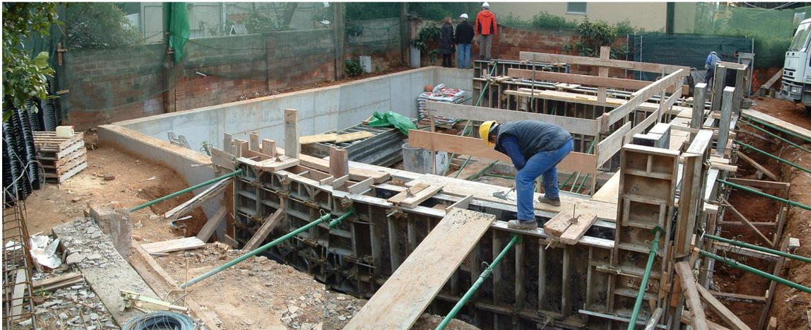
**Figura 78.** Encofrado de los muros de la Fase 2ª.
