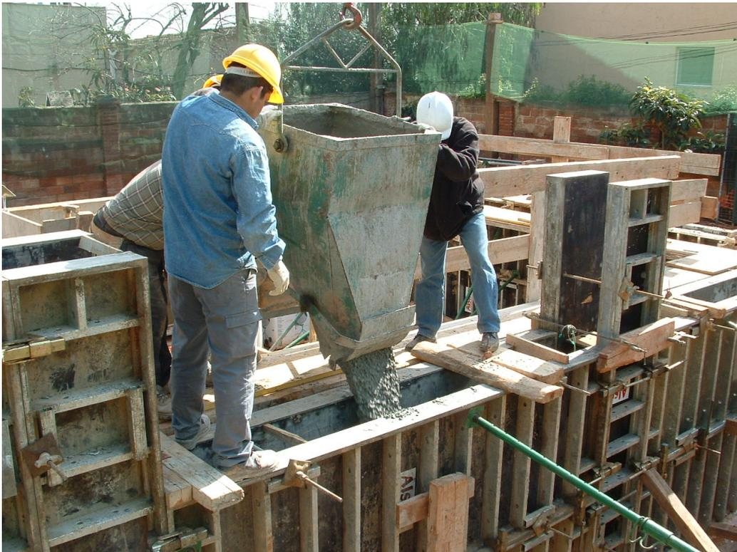
**Figura 79.** Detalles de la puesta en obra mediante cubilote.
