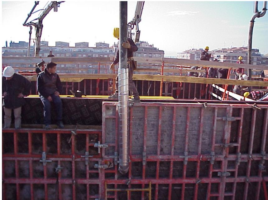
**Figura 7.** Detalle del sistema de hormigonado (Masó, 2008)
