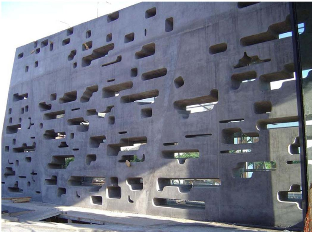
**Figura 15.** Muro hormigonado con HAC (BASF 2008)
