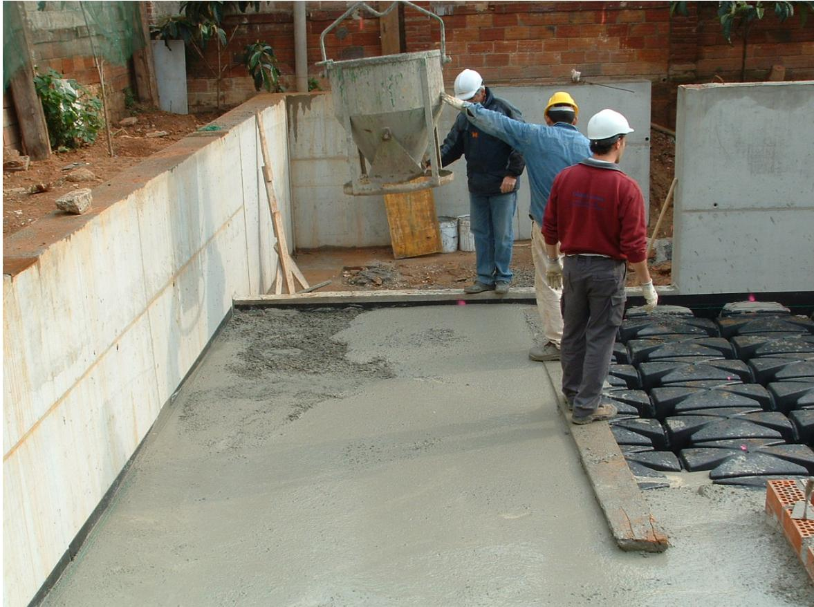
**Figura 80.** Puesta en obra del HACRF en la solera estudiada.
