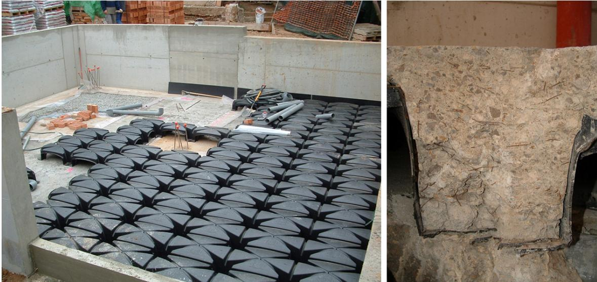
**Figura 75.** Sistema de encofrado no recuperable y detalle de los senos hormigonados con HACRF.
