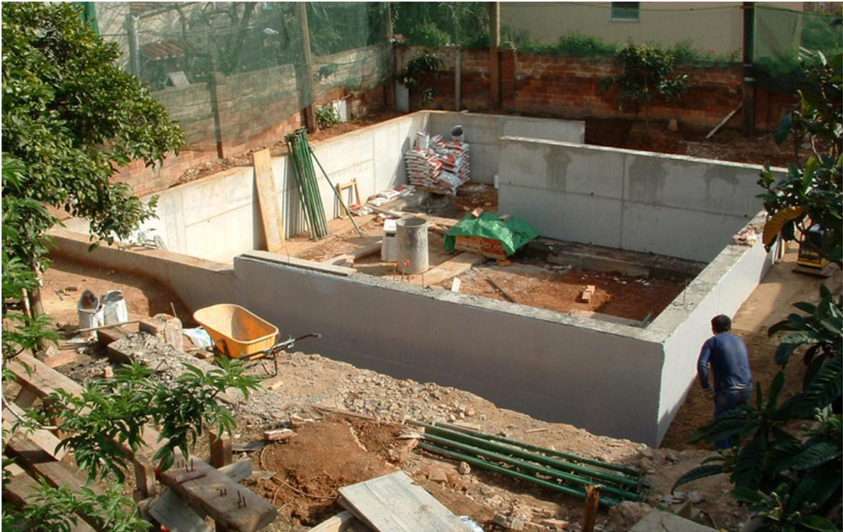
**Figura 84.** Aspecto final de los muros hormigonados con HAC.
