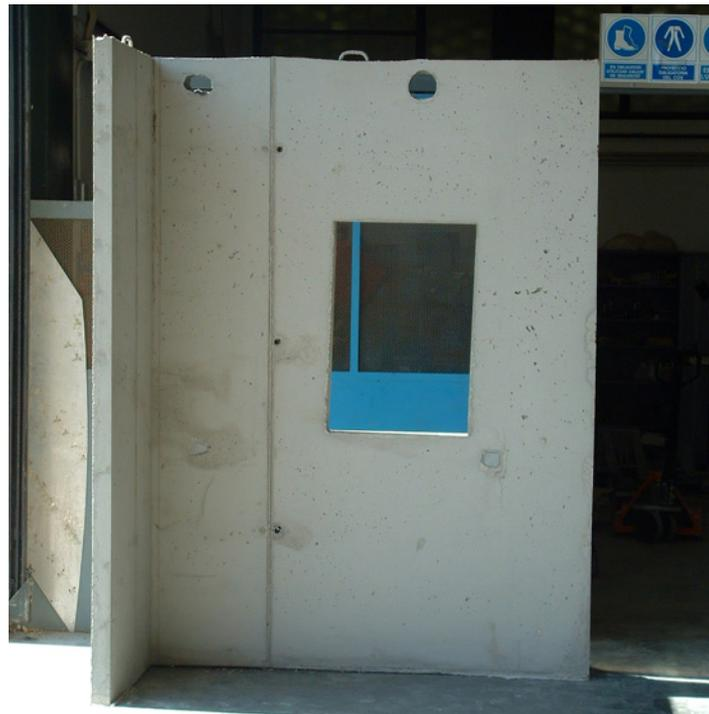
**Figura 69.** Aspecto de los paneles después de desencofrar.
