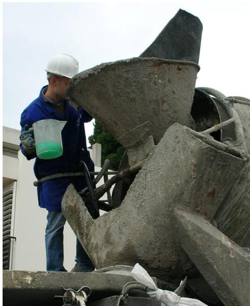
**Figura 20.** Re-dosificación de aditivo superplastificante a pie de obra.
