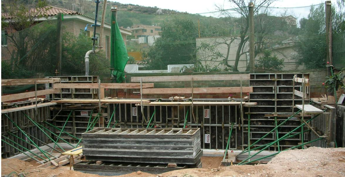
**Figura 77.** Fase 1ª del hormigonado de los muros.
