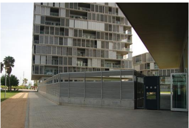
Illa de la Llum, arquitectos: Clotet i Paricio
