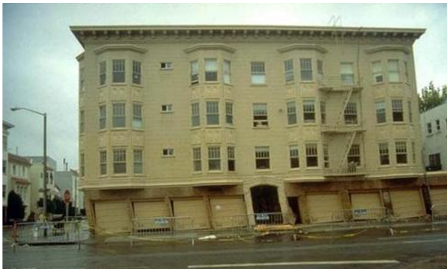
Figura 2.20 Edifici amb danys per un terratrèmol
