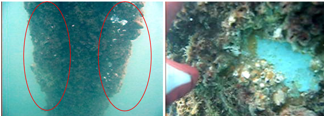
Fig. 14: Dos dels ànodes de zinc en diferent estat de degradació. El de l'esquerra encara està sencer i en canvi, el de la dreta ja ha perdut la forma cilíndrica original. La fotografia de la dreta permet comprovar que l'ànode de zinc de l'esquerra encara conserva el seu color original.
