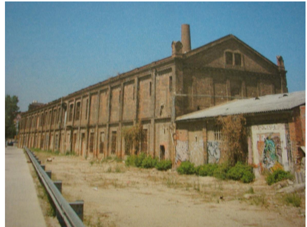
Fachada lateral C/ Fluvia
