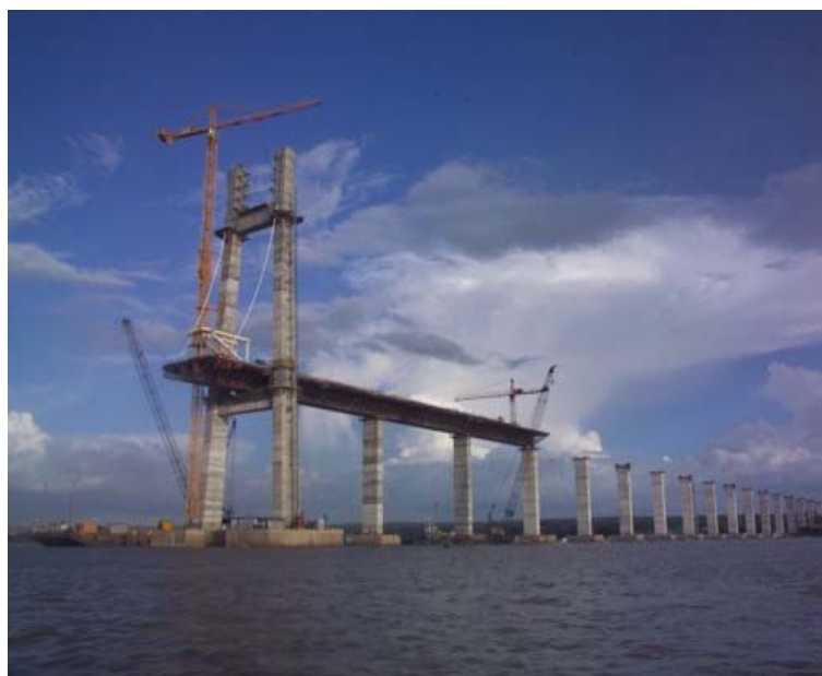
Fotografía 5 - Construcción 2º puente sobre el río Orinoco
