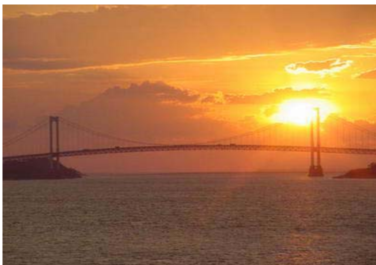
Fotografía 4- Puente de Angostura
