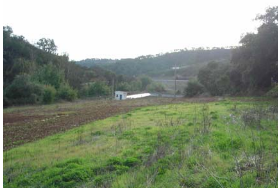
Fotografía 13. Vista de la EDAR de Luzianes.
