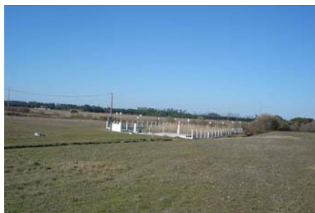
Fotografía 19. Vista de la EDAR de Malavado.
