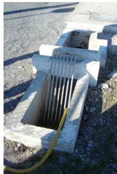
Fotografía 18. Obra de entrada y fosa séptica de Malavado (a la izquierda y derecha respectivamente).
