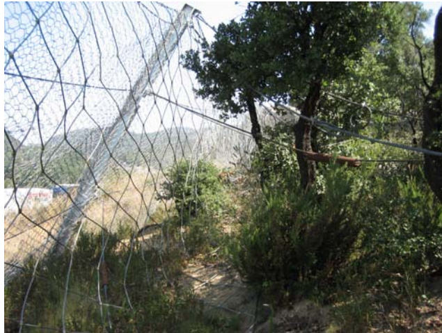
Figura 5: ejemplo real de pantalla dinámica de acero, en la que se observa la magnitud de los componentes.
