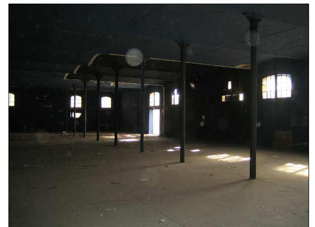
Imagen del interior de la planta baja de la Nave 1.
