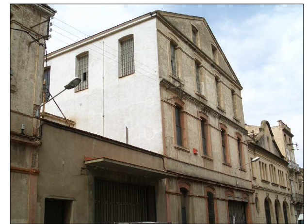
Imagen del exterior de la Nave 2 desde la Calle Churruca.
