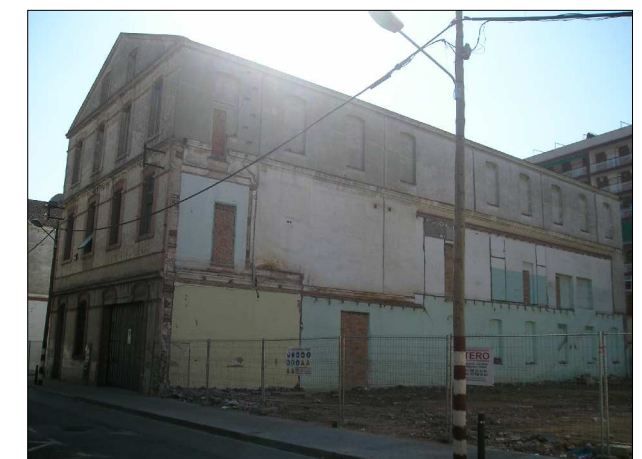
Imagen del exterior de la Nave 2 desde la Calle Churruca.
