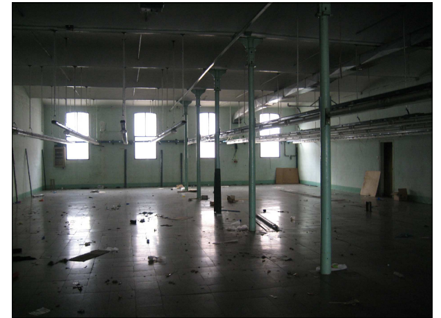
Imagen del interior de la planta primera de la Nave 2.
