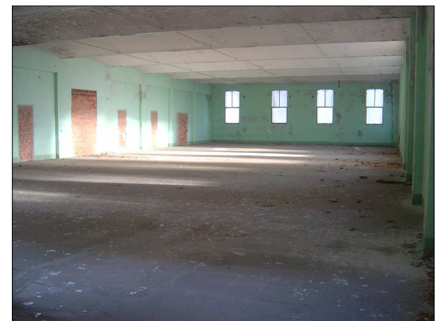
Imagen del interior de la planta primera de la Nave 1.
