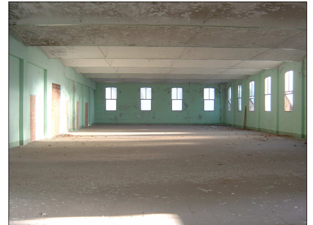
Imagen del interior de la planta baja de la Nave 2.
