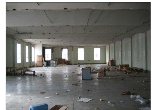
Imagen del interior de la planta segunda de la Nave 2.
