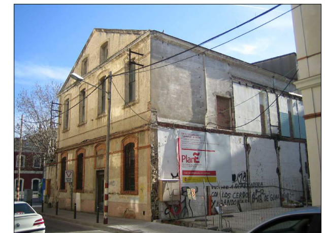
Imagen del exterior de la Nave 1 desde la Calle Churruca.
