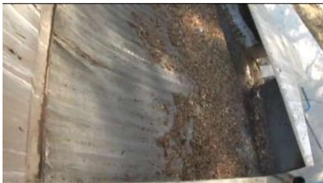
Ilustración 14 - Tamizado 7 Fuente: Fotos tomadas de un video de la planta de tratamiento de aguas residuales en Jalisco, México.
