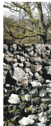
(7) La disposición de las piedras en los muros y la ausencia de material adherente permite el paso del agua.
