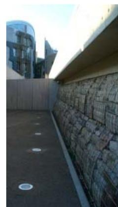
(22) El muro se ha construido con las propias piedras de los edificios pre-existentes del solar. A su vez un ensayo previo en la conocida obra del cementerio de Igualada de 1985-91.
