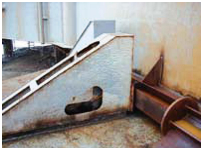
Imagen n° 36: Refuerzos Longitudinales/Transversales
