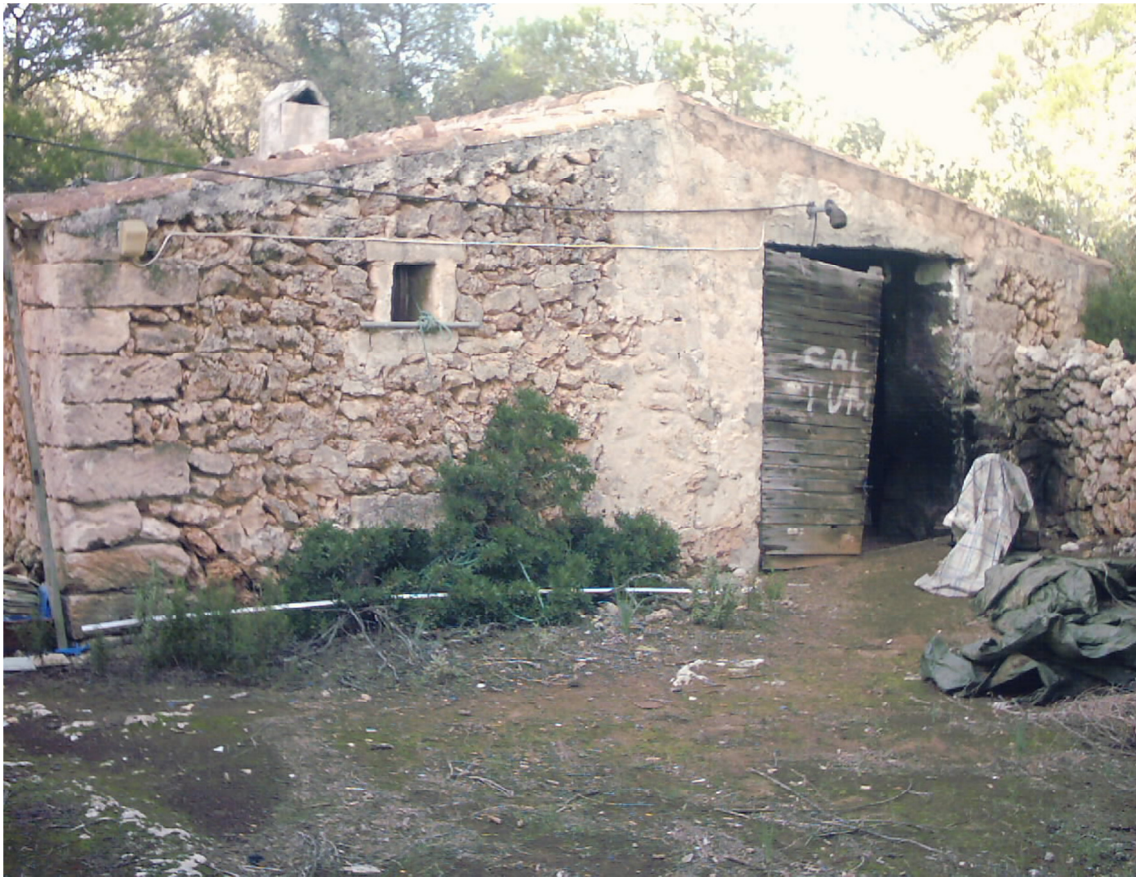
Caseta d'instal·lacions abans de la rehabilitació.
