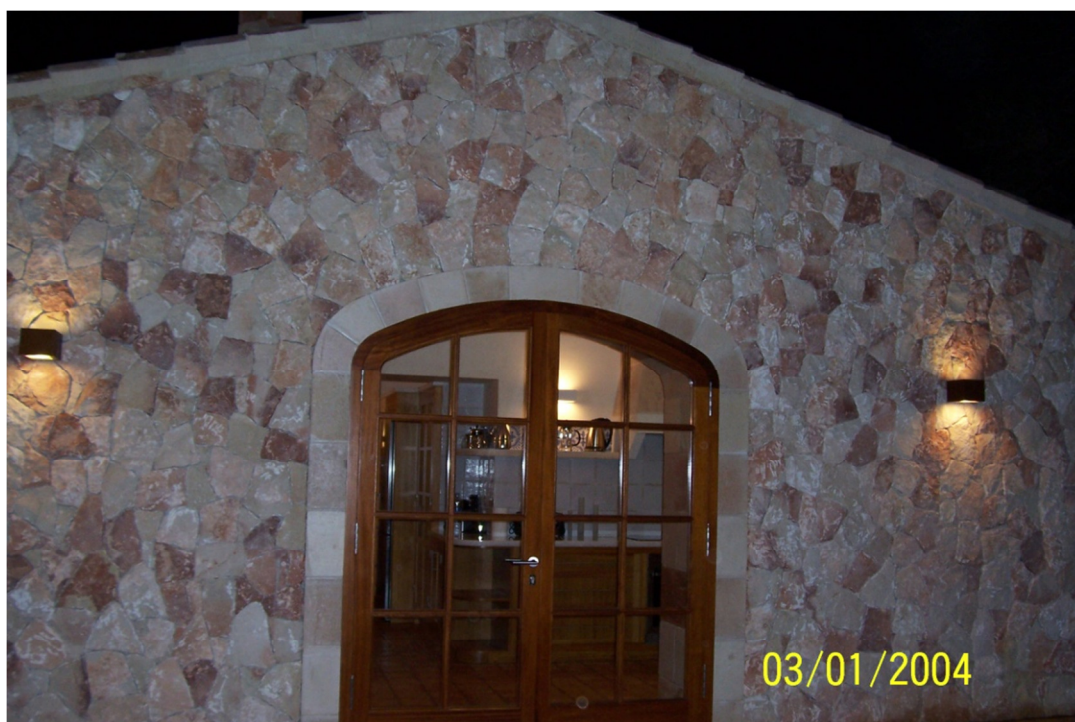
Caseta del guarda després de la rehabilitació. Anomenada com a –Casa de convidats-.
