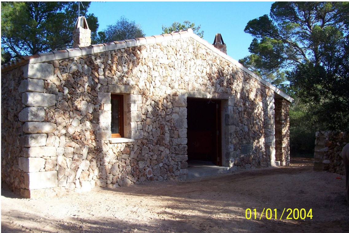
Estat final després de la rehabilitació – Caseta d'instal·lacions-
