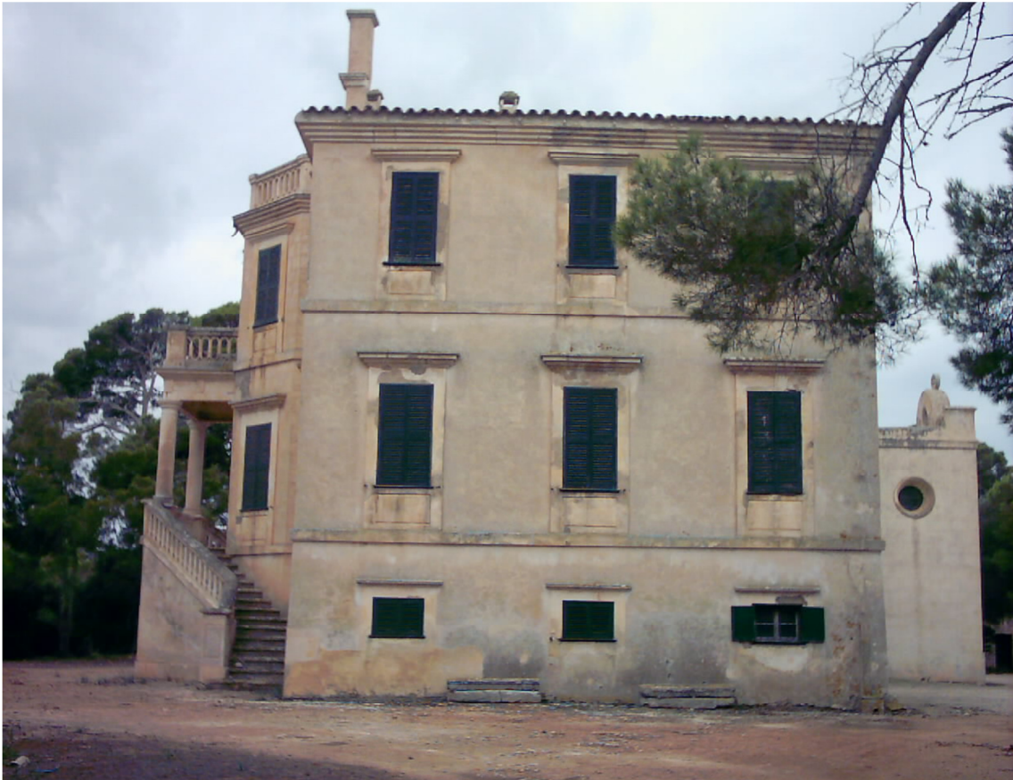
Estat abans de la rehabilitació
