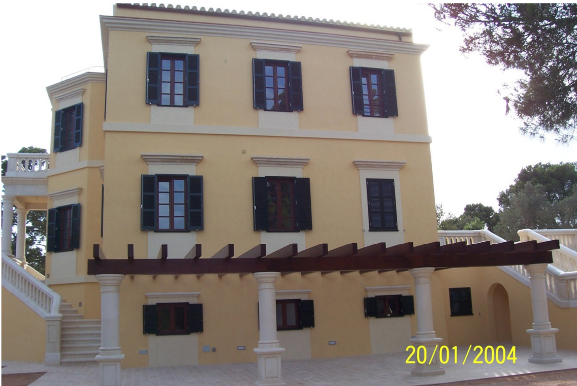
Estat de l'edifici rehabilitat
