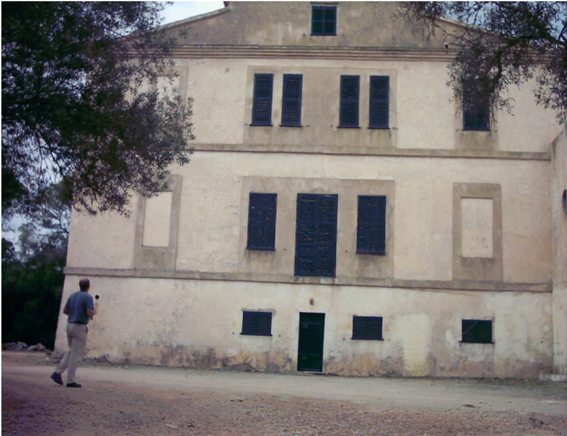
Estat abans de la rehabilitació
