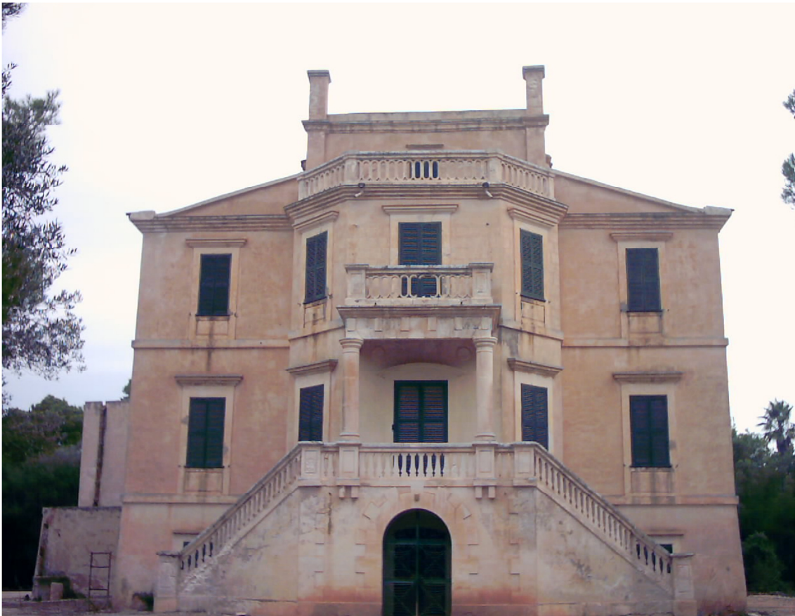
Estat abans de la rehabilitació
