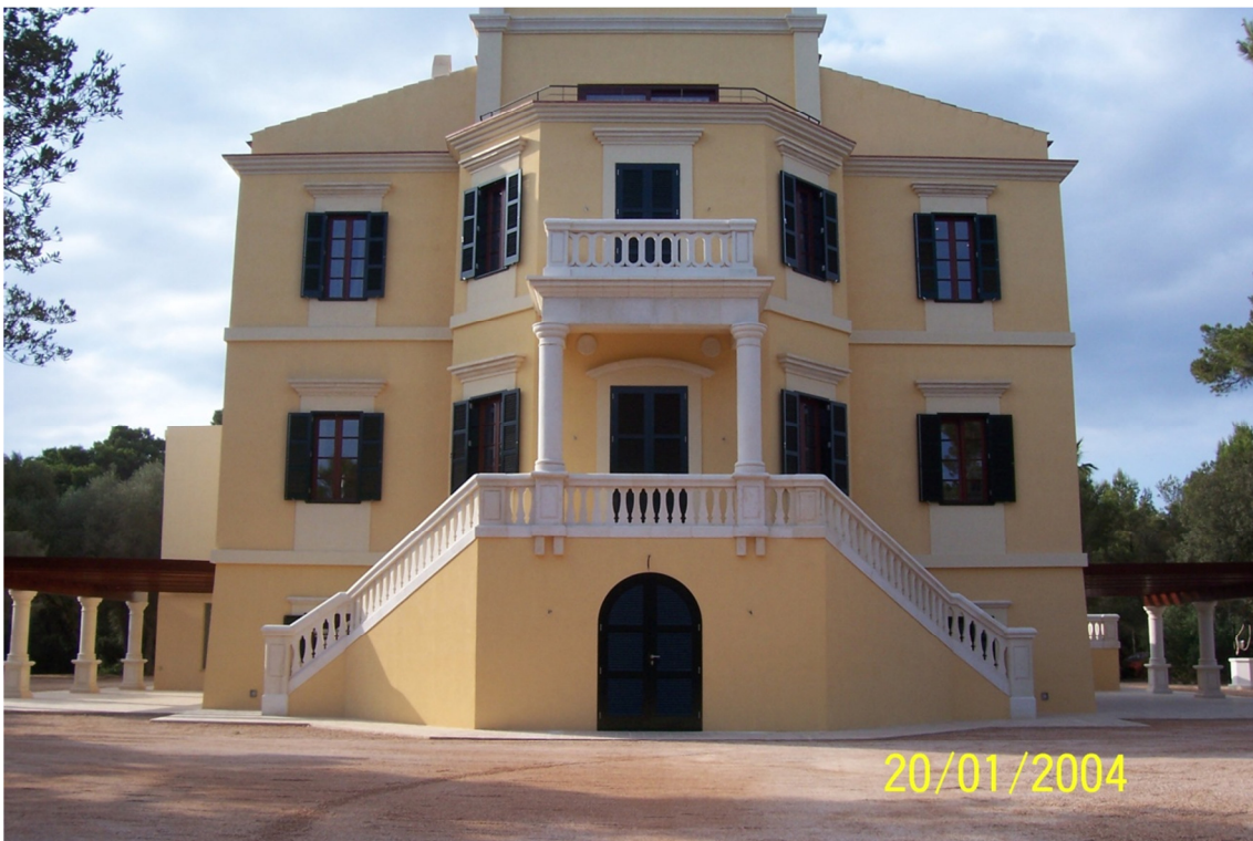
Estat de l'edifici rehabilitat
