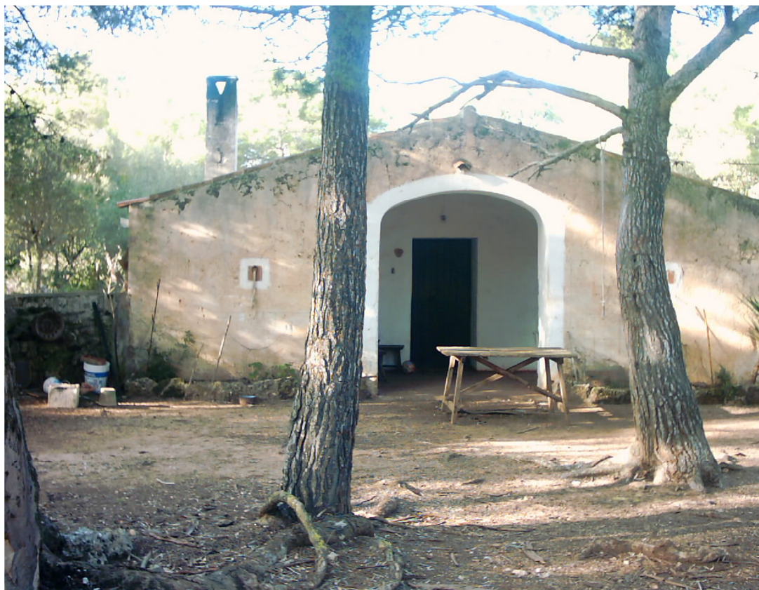
Caseta del guarda abans de la rehabilitació.
