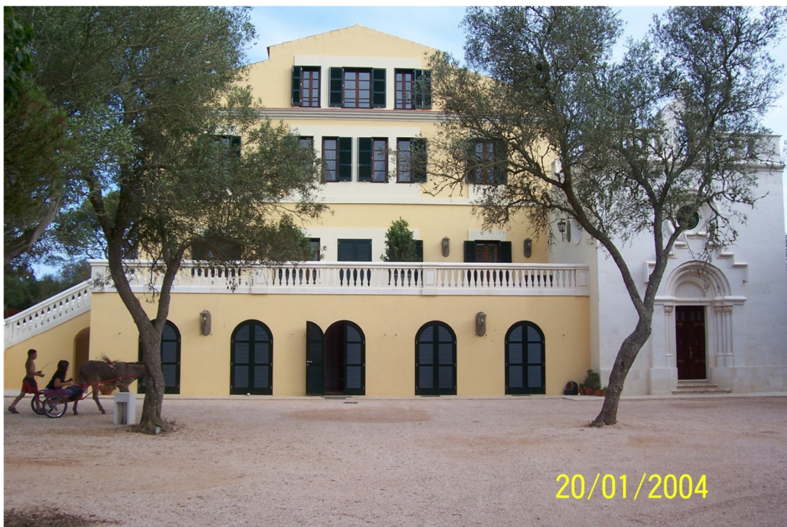
Estat de l'edifici rehabilitat
