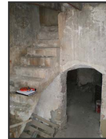
IMAGEN 42. LAS ESCALERAS ESTÁN FORMADAS CON UN ARCO A LA CATALANA, QUE APOYA EN LOS MUROS DE CARGA.
